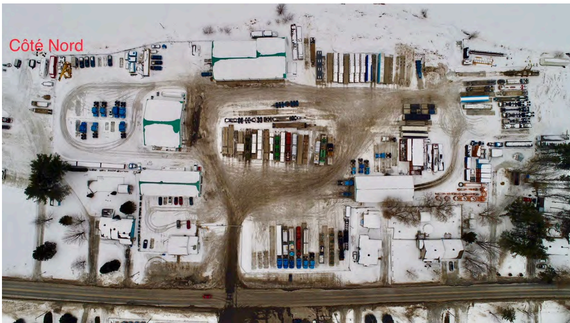
Photo 5 : Illustration du manque d'espace et de la circulation sur le site / Section au nord du chemin Grande Côte Ouest, Lanoraie (hiver 2019)
