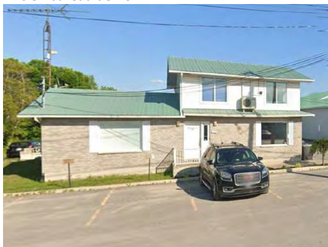
Ancien bureau démol
