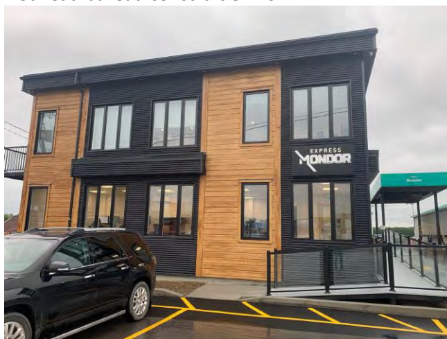
Nouveau bureau construit en 2022
