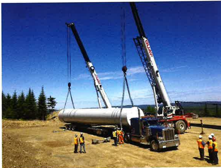
Déchargement d'une section de tour d'éolienne au site d'exploitation d'un parc éolien
