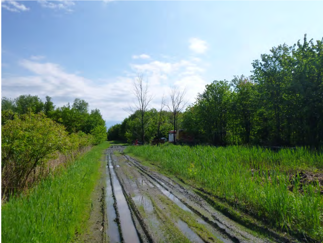
Photo 5 : chemin d'accès où l'on voit les marges du chemin sous couverture végétale.
