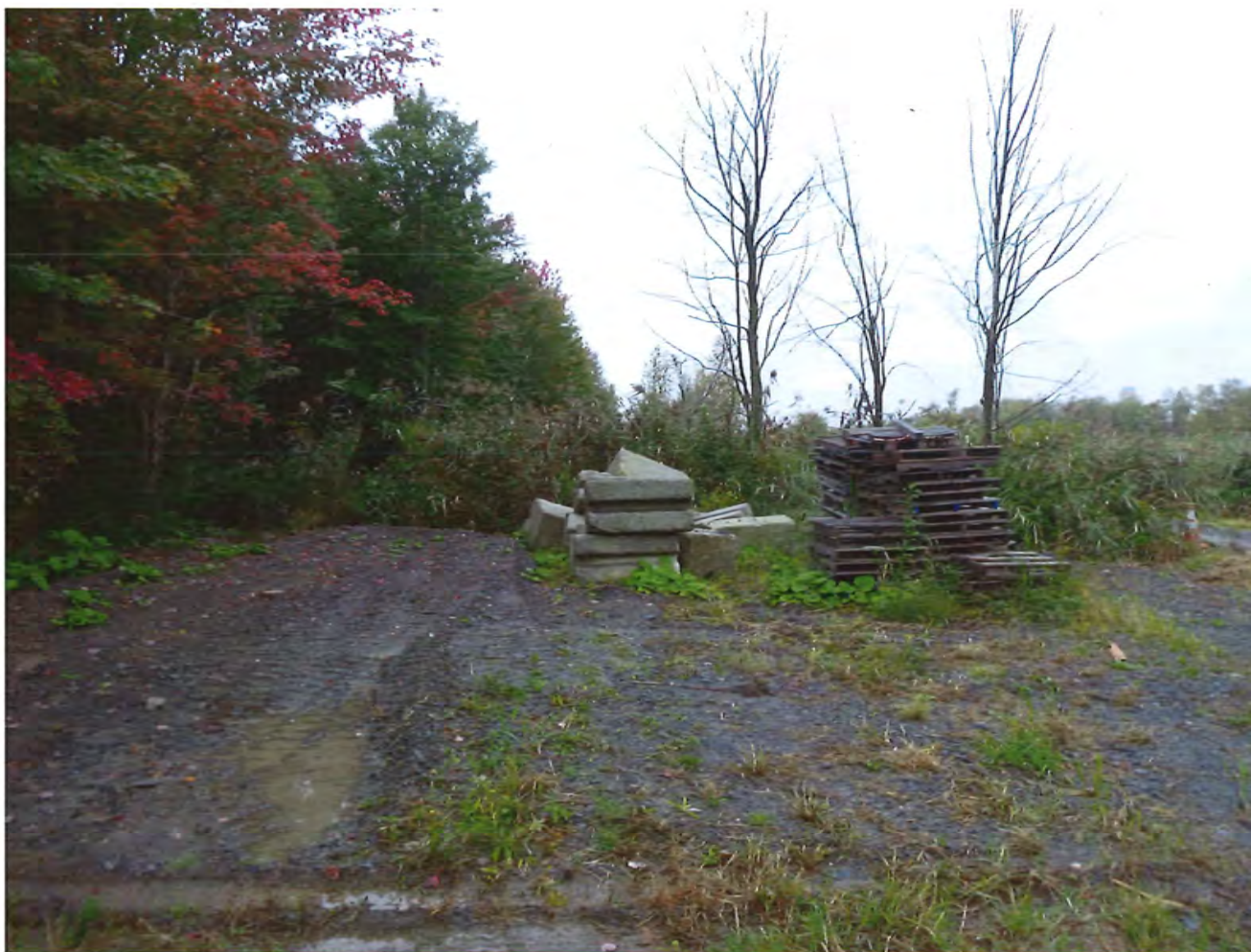
Photo 14 : Béton, palettes de bois.
