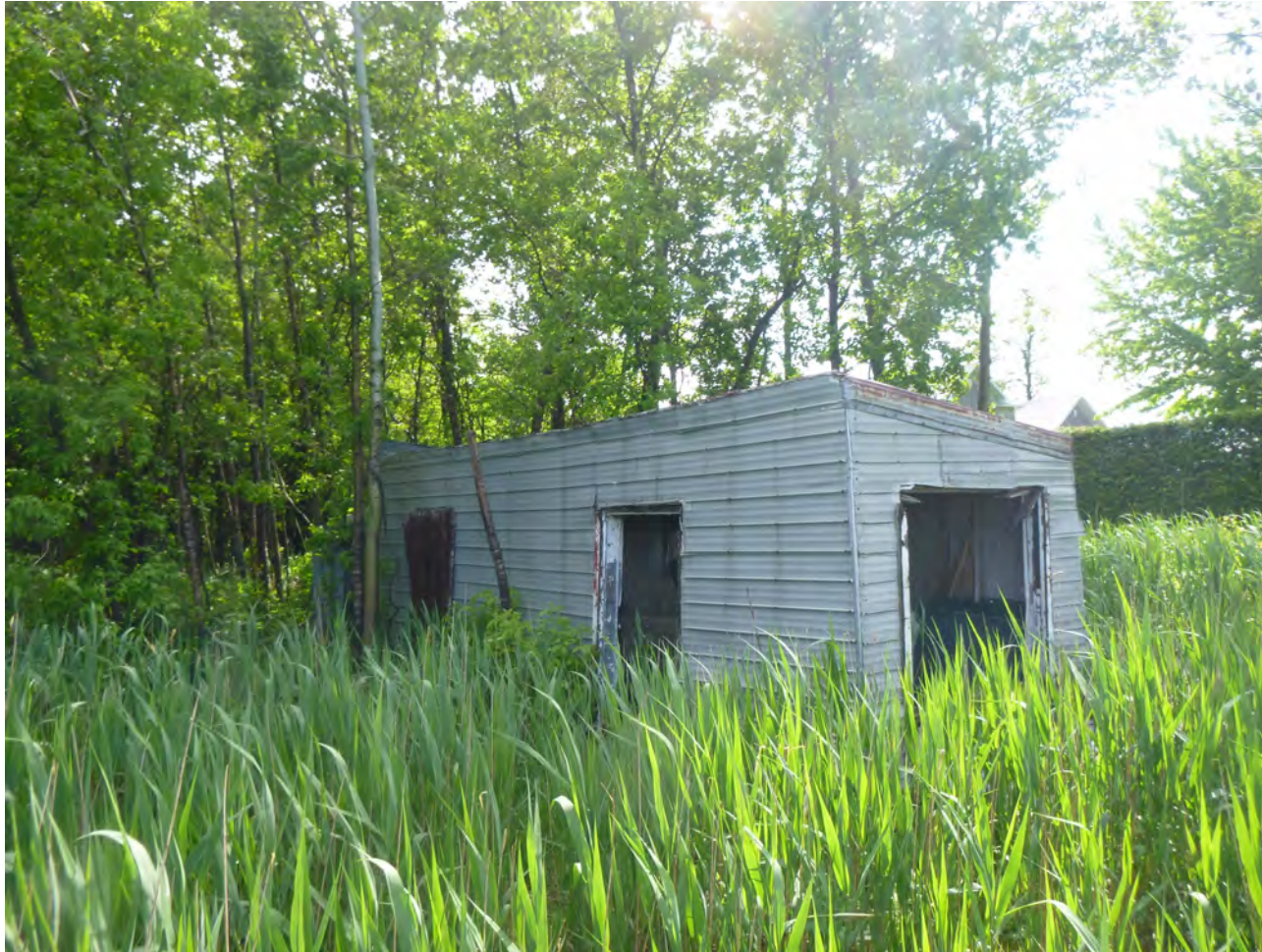
Photo 2 : cabane à proximité de l'entrée du chemin d'accès.
