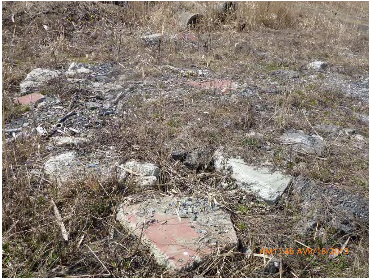
VUE RAPPROCHÉE DES MATÉRIAUX DÉVERSÉS
