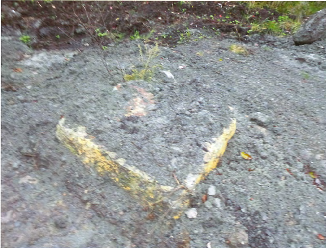
Photo 4 : Bloc de béton.
