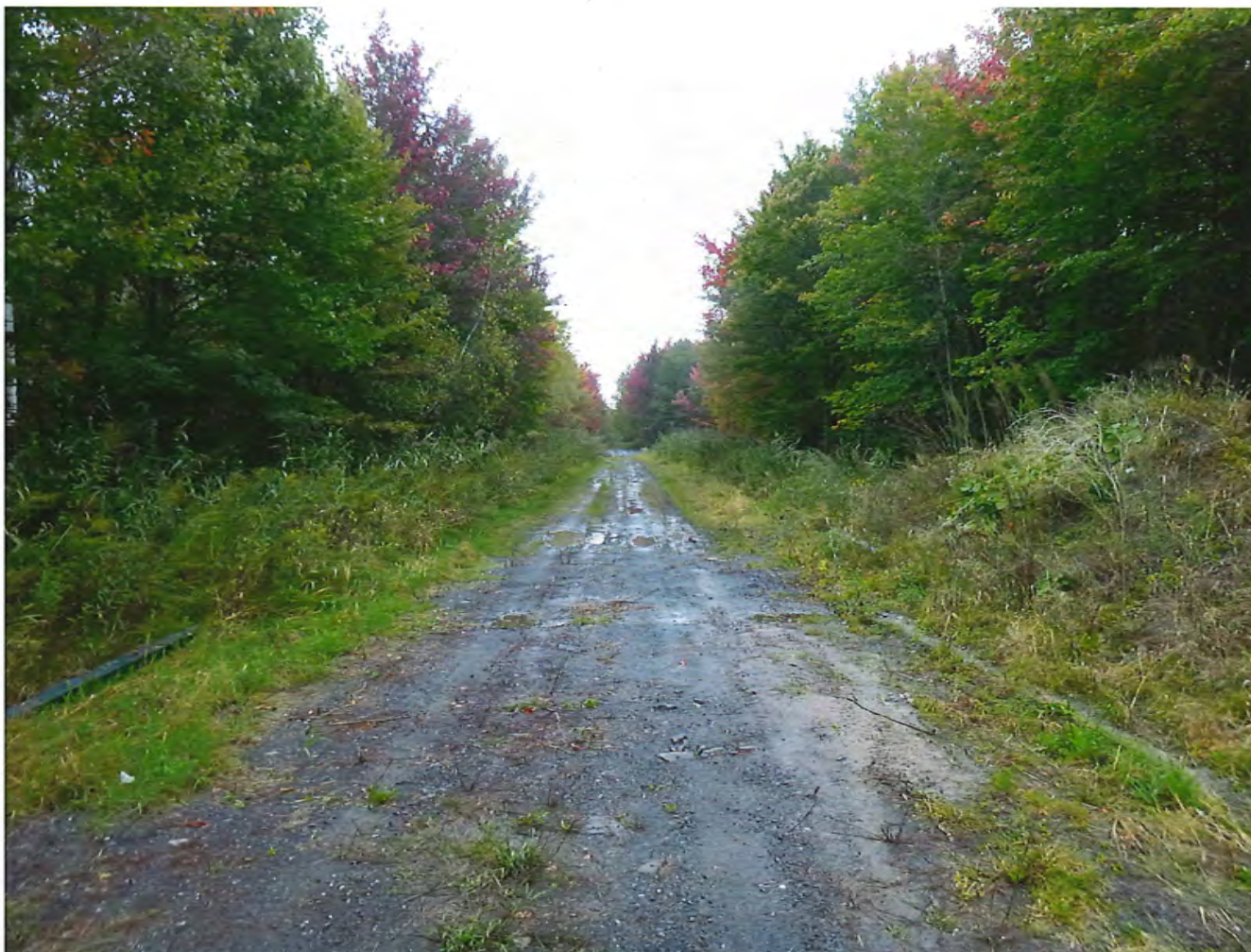
Photo 15 : Marges du chemin sous couvert végétal.
