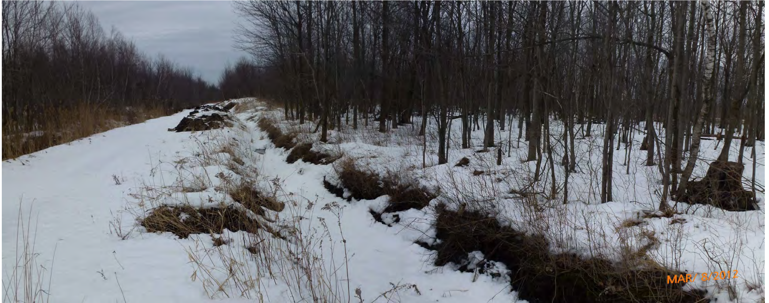
Deuxième site : enlèvement de sol (terre noire) et dépôts de matériaux d'excavation pour combler site excavé
