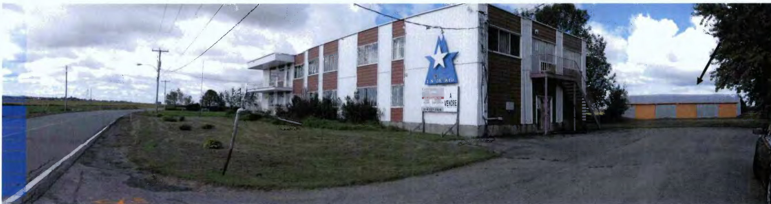
Balayage photographique montrant la façade de la propriété. (M.G. 24-09-2009)
