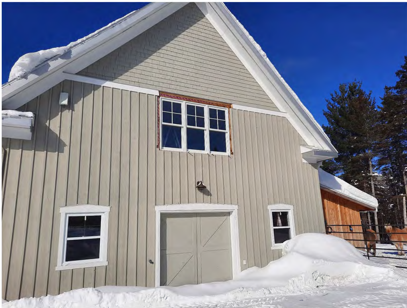
Photo 7 : Fenêtre nouvellement installée
