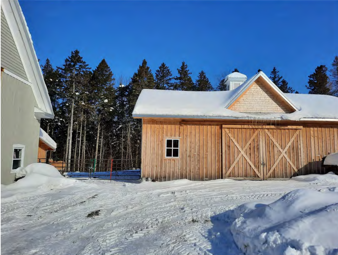
Photo 6 : Nouveau bâtiment utilisé comme grange
