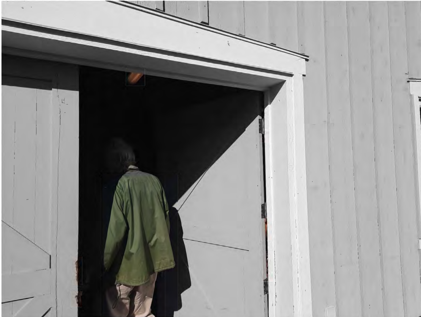
Photo 2 : Entrée par l'écurie du bâtiment.
