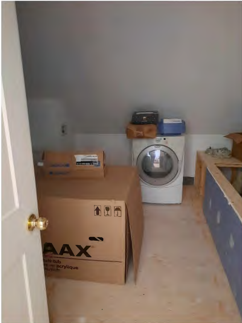
Photo 22 : Salle de bain non terminée.
