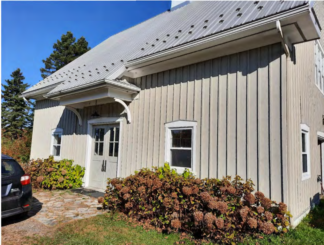
Photo 1 : Vue de l'entrée du bâtiment.
