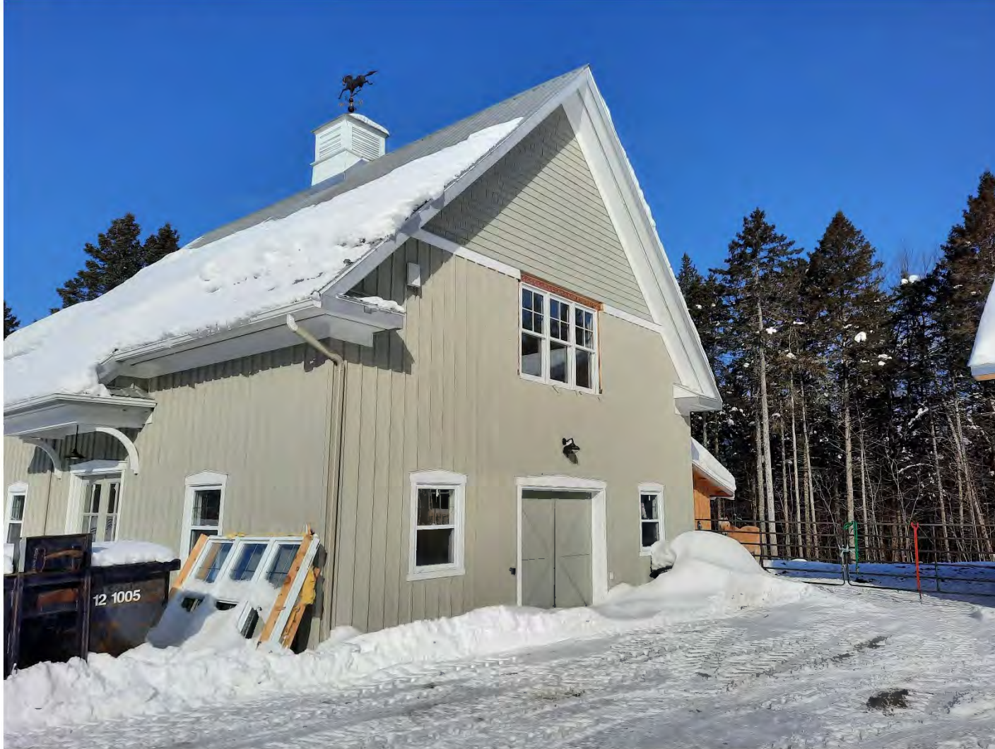
Photo 5 : Côté de l'écurie
