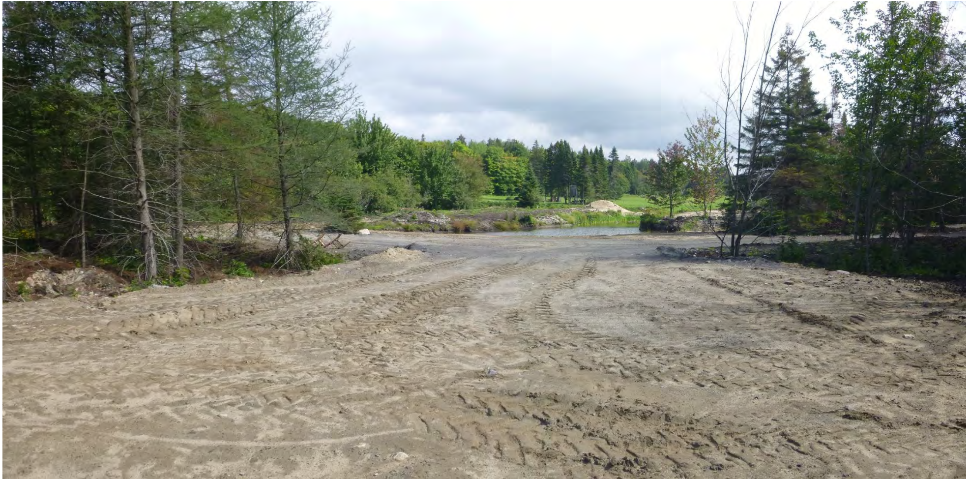
Vues d'ensemble du lac artificiel aménagé sur le lot visé
