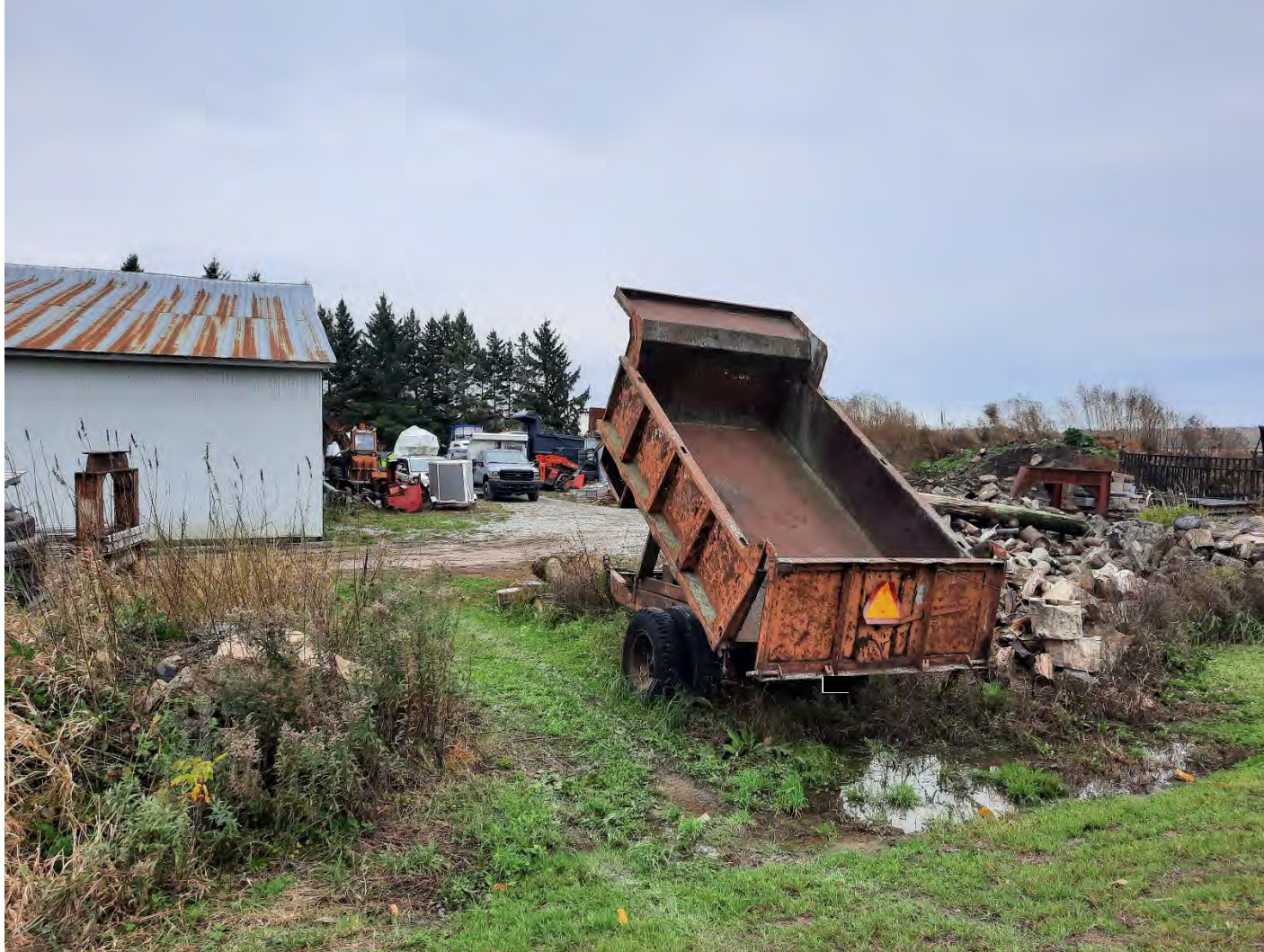
Photo 15 : Vue du côté sud-ouest du bâtiment.
