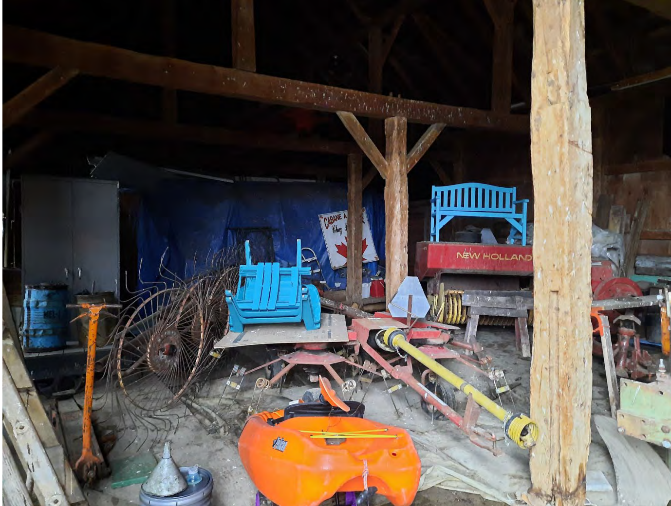
Photo 11 : Intérieur du bâtiment côté nord-ouest.
