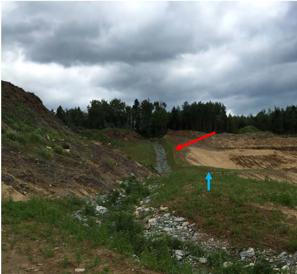
Photo 1 : Fossé au nord-ouest (flèche rouge) et bassin de rétention aménagé à la cote de niveau 184 mètres (flèche bleue).
