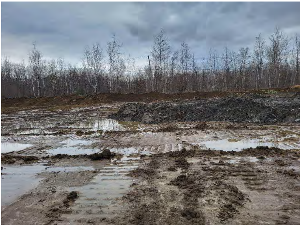
Photo 31 : Limite du terrain excavé et du remblai en cours, vue en direction nord-ouest
