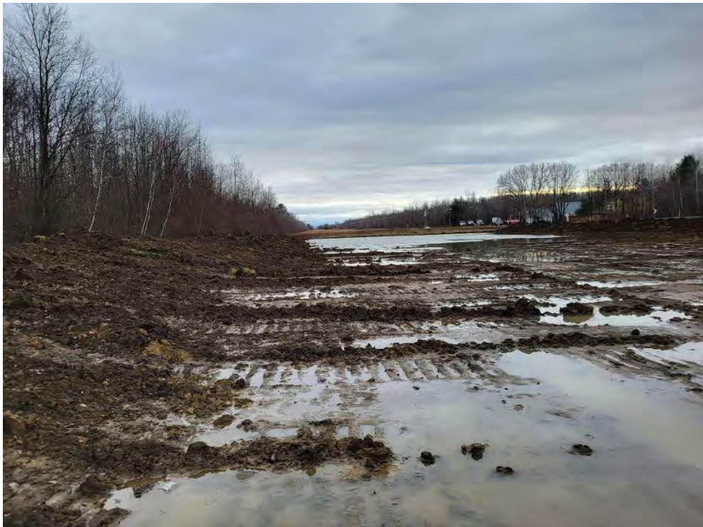
Photo 33 : Terre arable excavé pour le remblai, vue en direction sud
