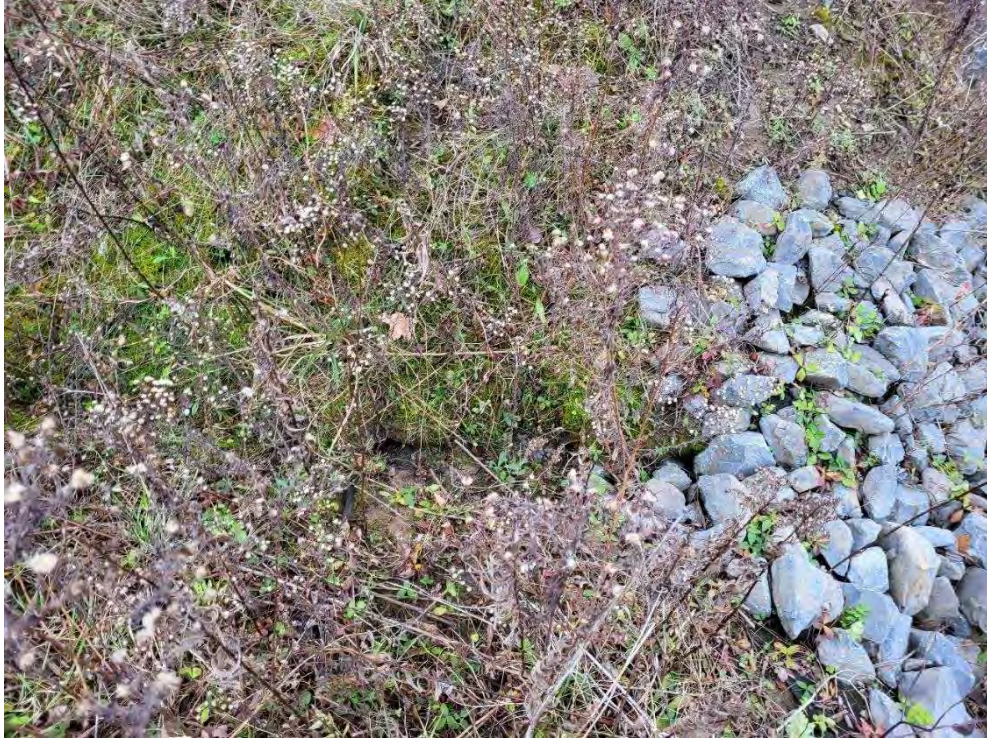
Photo 3 : Rigole avec sortie enrochée dans le cours d'eau du milieu
