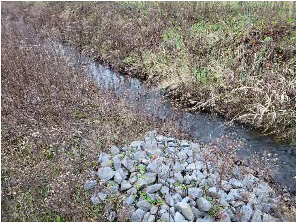
Photo 4 : Cours d'eau du milieu situé entre les parcelles
