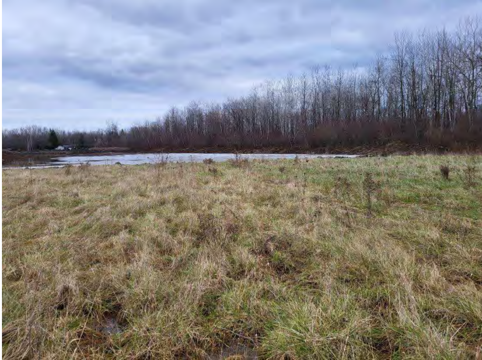
Photo 7 : Terrain naturel et vu du remblai en cours, vue en direction nord-est
