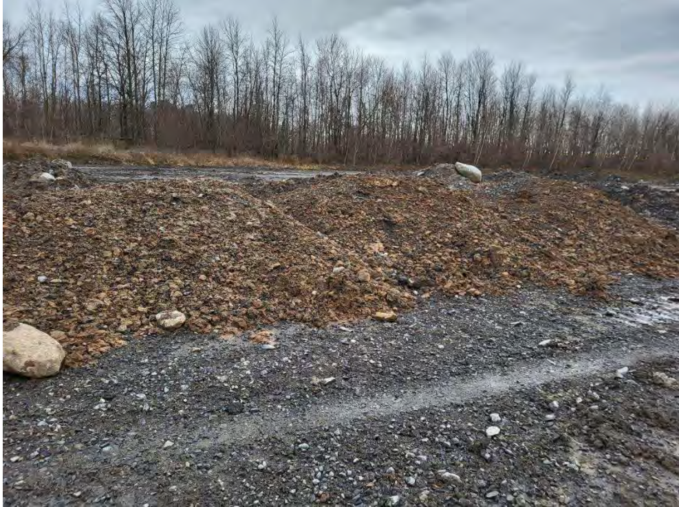
Photo 19 : Amas de matériel sur le remblai, section nord du lot
