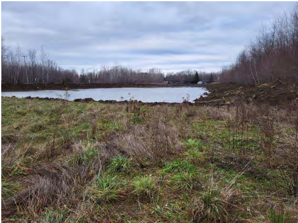
Photo 10 : Terrain excavé pour le remblai, vue en direction nord
