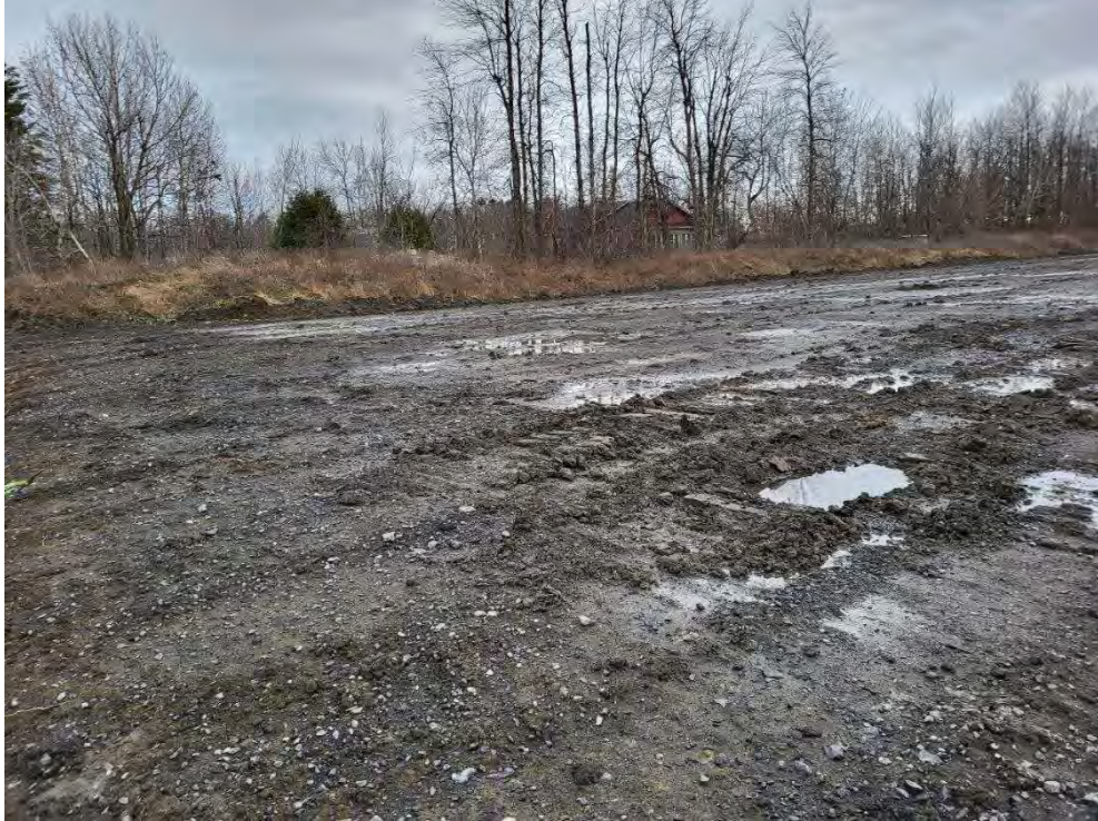
Photo 23 : Remblai en cours, vue en direction sud-ouest
