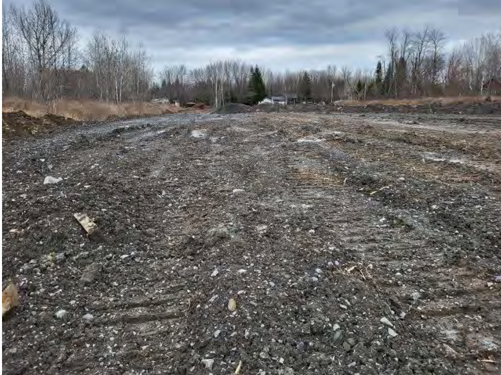
Photo 17 : Remblai en cours dans la section nord de la parcelle
