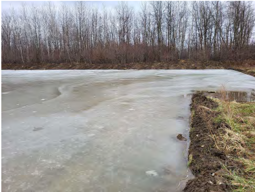
Photo 13 : Terrain excavé pour le remblai, vue en direction nord-est
