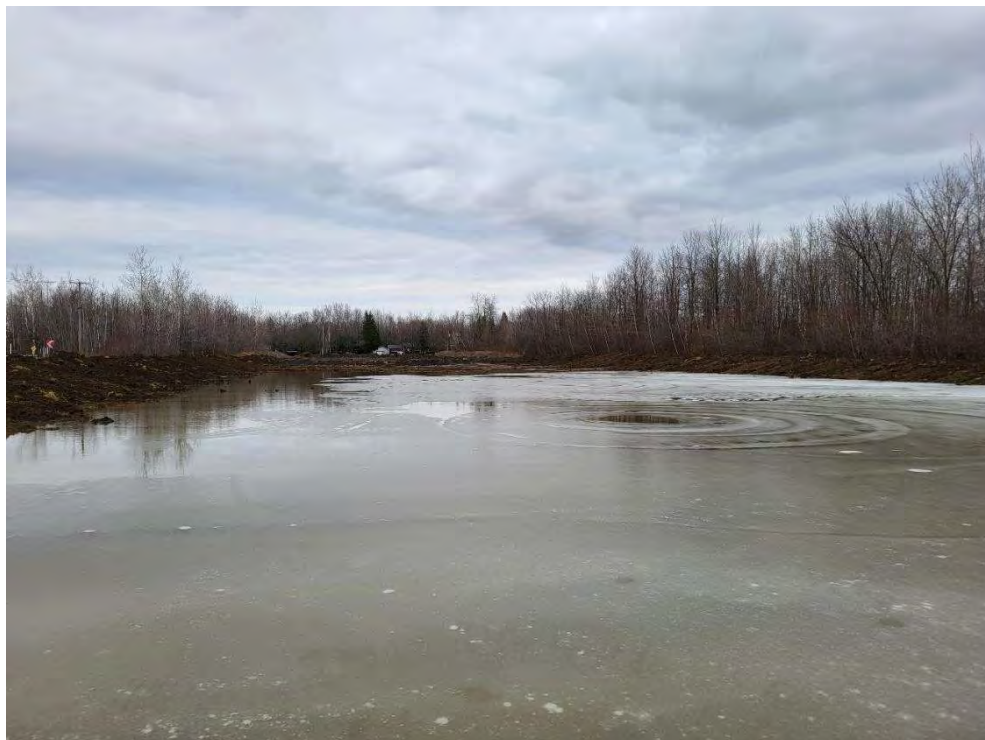
Photo 14 : Terrain naturel excavé pour le remblai, vue en direction nord-est
