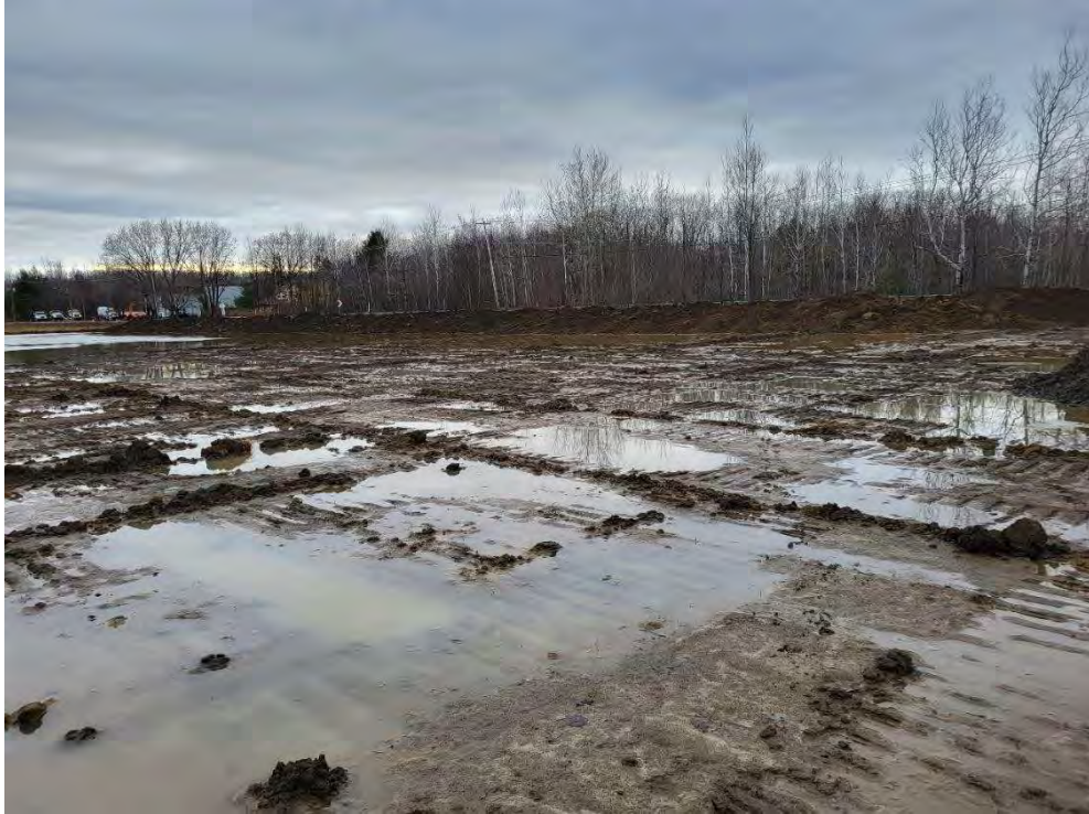
Photo 32 : Terrain excavé pour le remblai, vue en direction ouest
