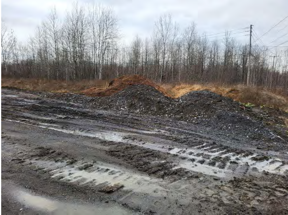
Photo 25 : Photo 26 : Amas de matériel de remblai près de l'entrée d'accès au champ
