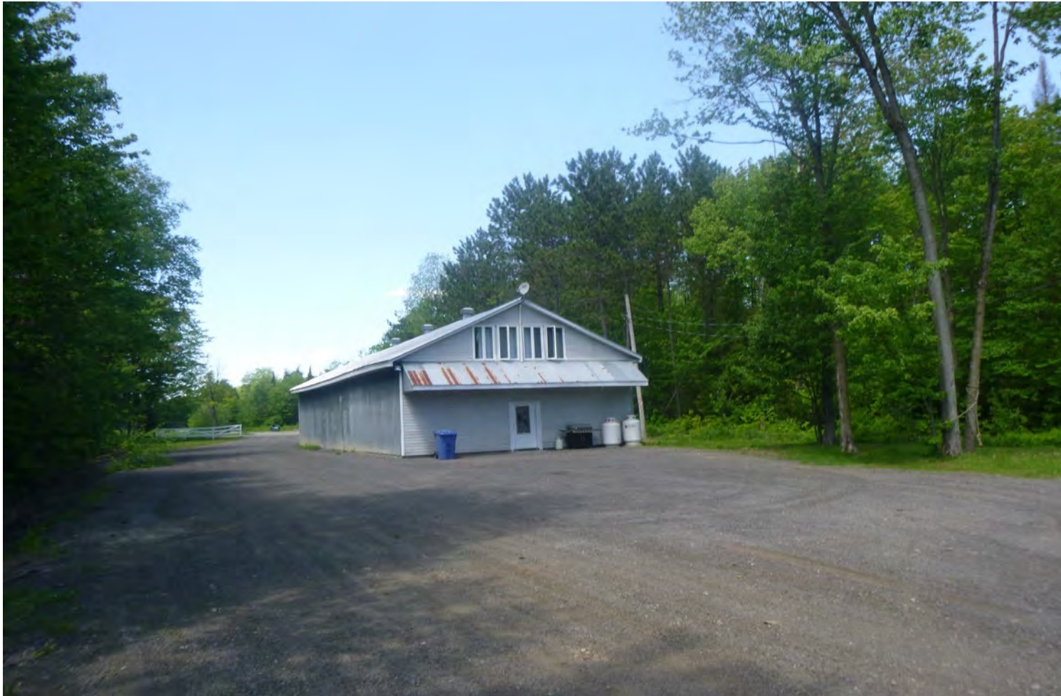
Photo 8 : Bâtiment en bordure du chemin public dans lequel on retrouve une partie résidentielle.
