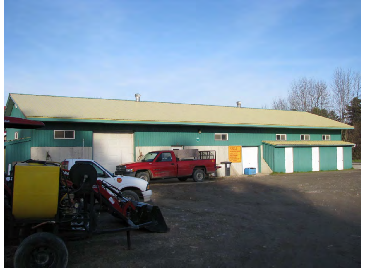
Description : Atelier et entreposage
