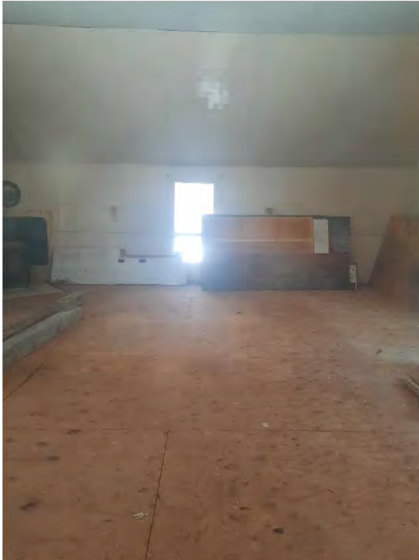
Intérieur du bâtiment.
