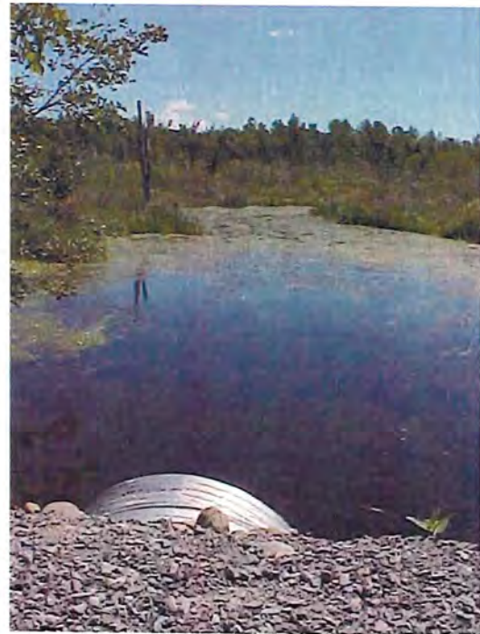
Figure 18 : Ponceau entre seg.1 et 2
