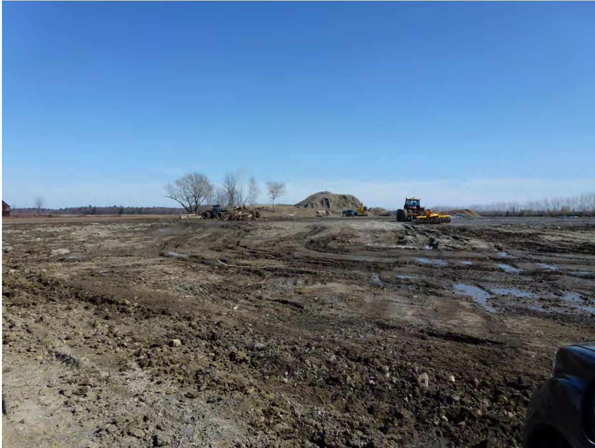
Description : Emplacement remblayé faisant l'objet de nivellement avec une sole.
