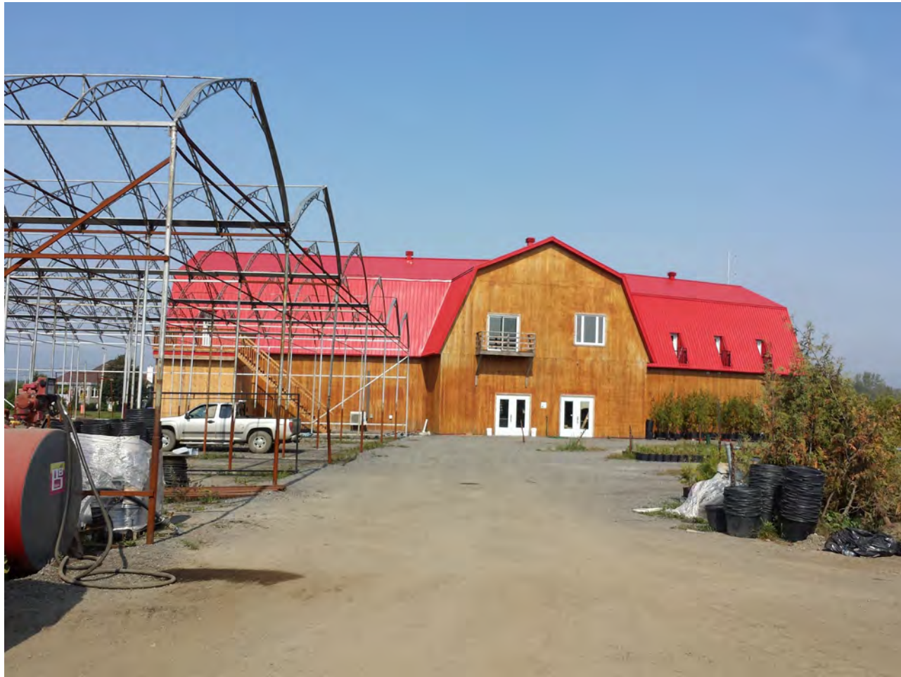
Photo 6 : bâtiment vu de l'arrière.
