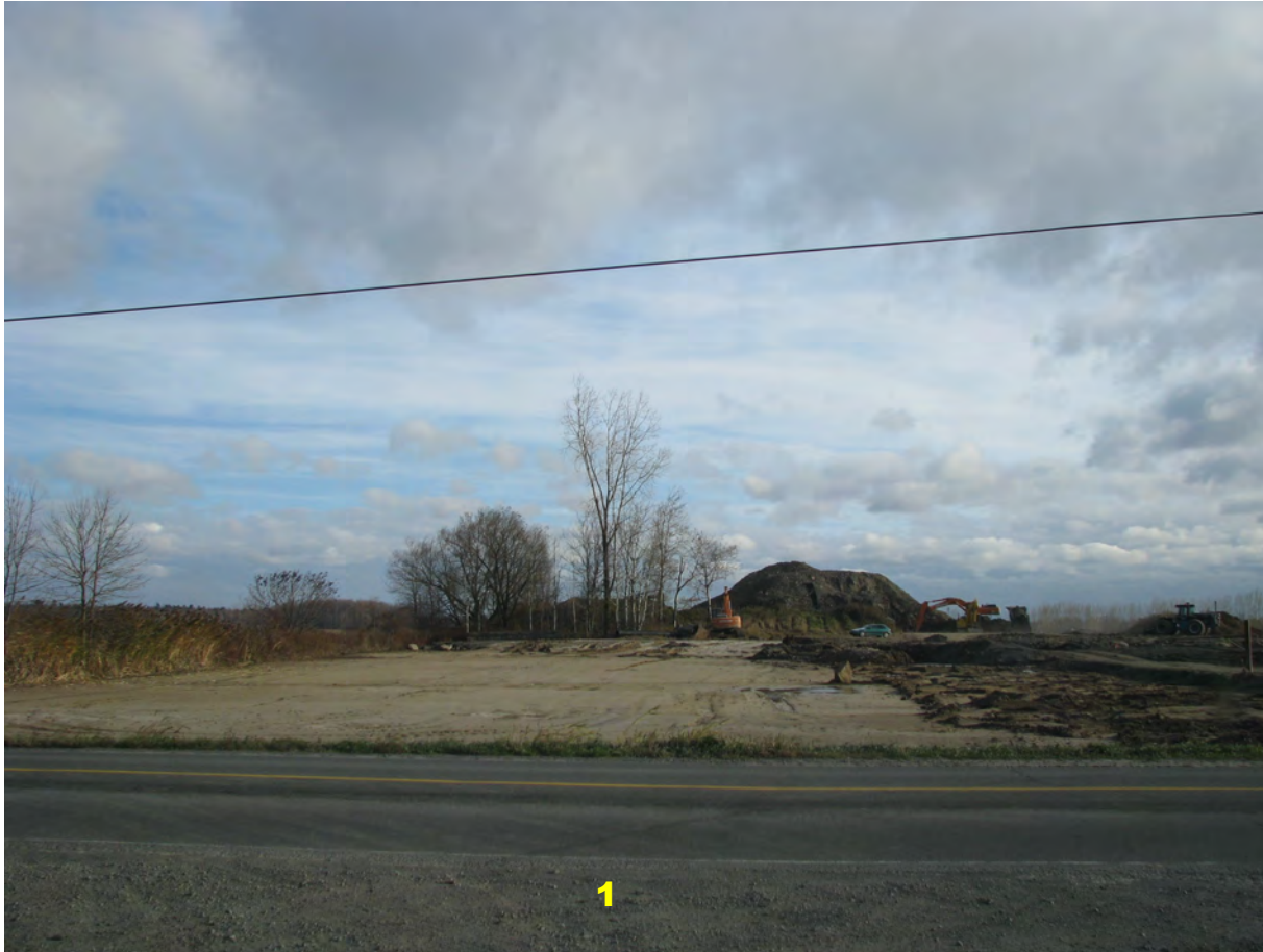
Description : Aire de 4 000 mètres carrés ayant fait l'objet de décapage
