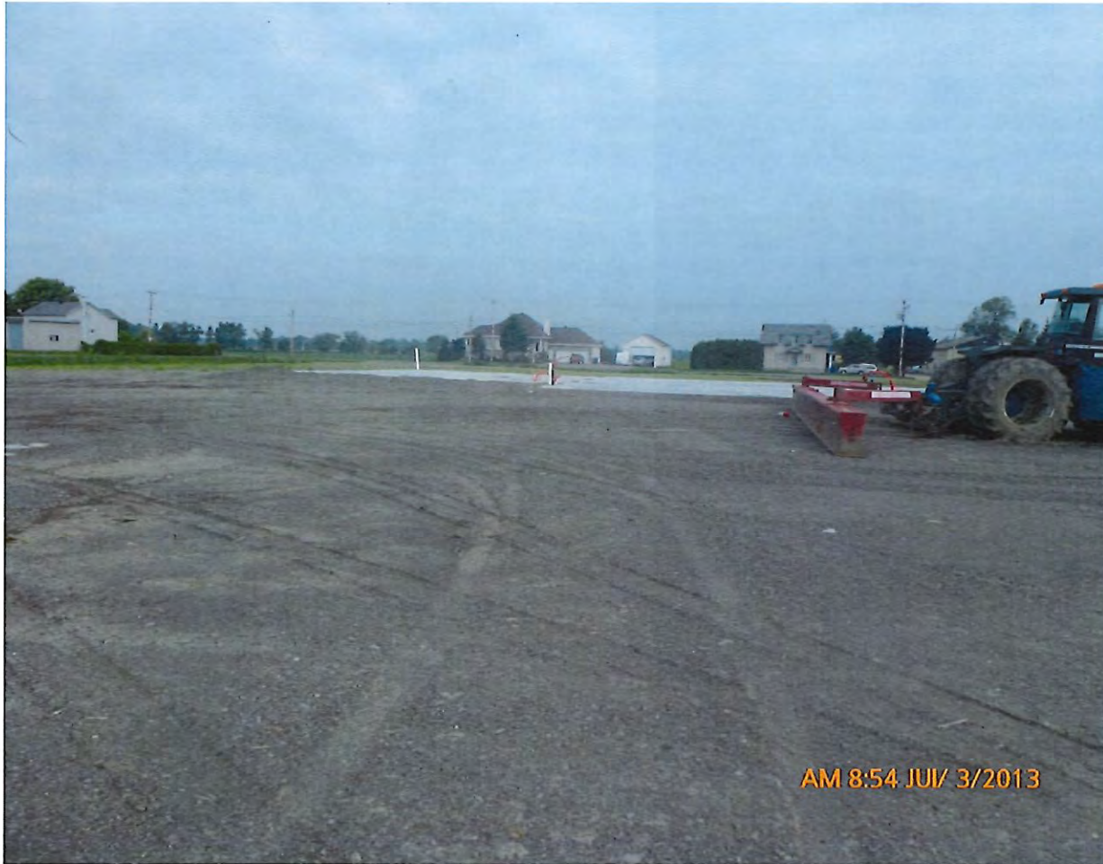
Fondations des futurs aménagements et nivellement du site
