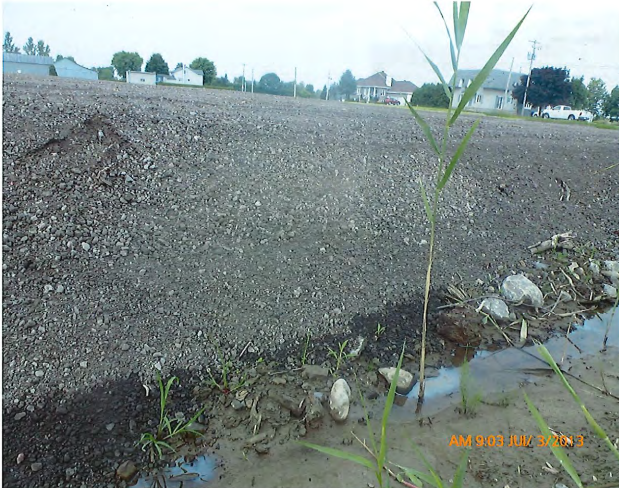
épaisseur du remblai au niveau du chemin d'accès : 2 à 3 pieds
