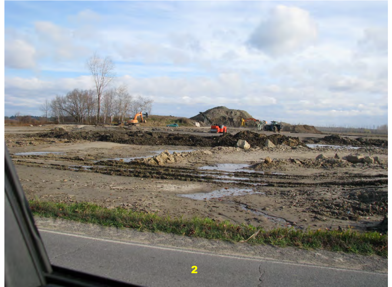
Description : Aire de 3 000 mètres carrés ayant fait l'objet de décapage
