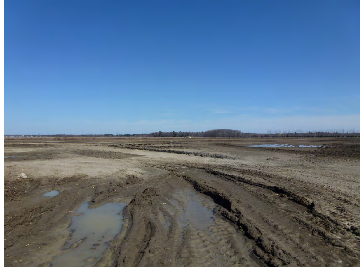
Description : Remblai devant les serres projetées.
