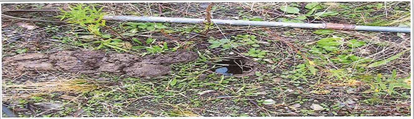
Photo 6. Vérification de l'épaisseur de sol arable étendu.
