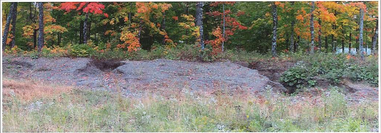
Photo 7. Érosion dans les talus, pentes trop abruptes du côté de la forêt à l'ouest.
