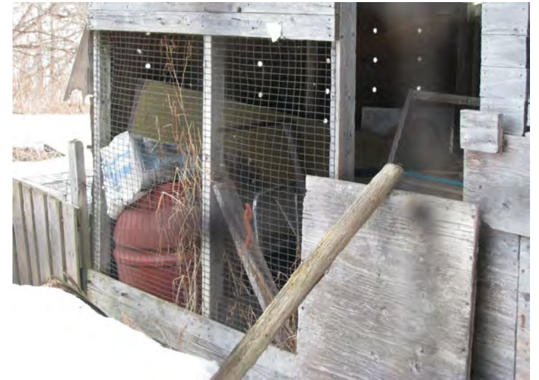
Annexe derrière la grange.
