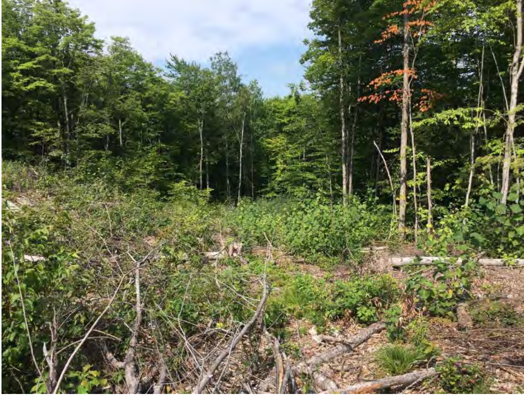
Photo 1. Déboisement chemin d'accès
