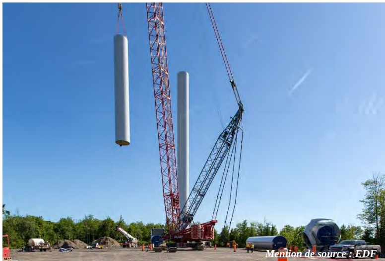
Figure D.1 Assemblage d'une tour et d'une pale d'éolienne
