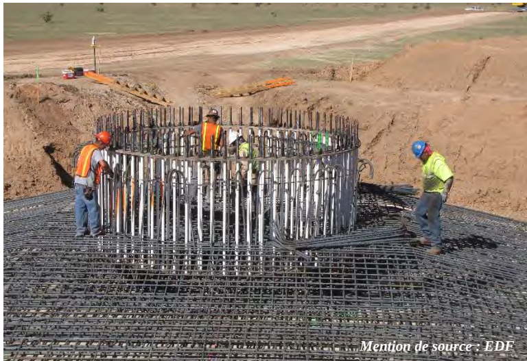
Figure D.2 Construction d'une fondation d'éolienne de type gravitaire
