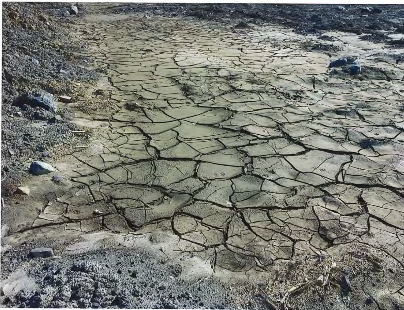
Photo 29 : Partie sèche du remblai
