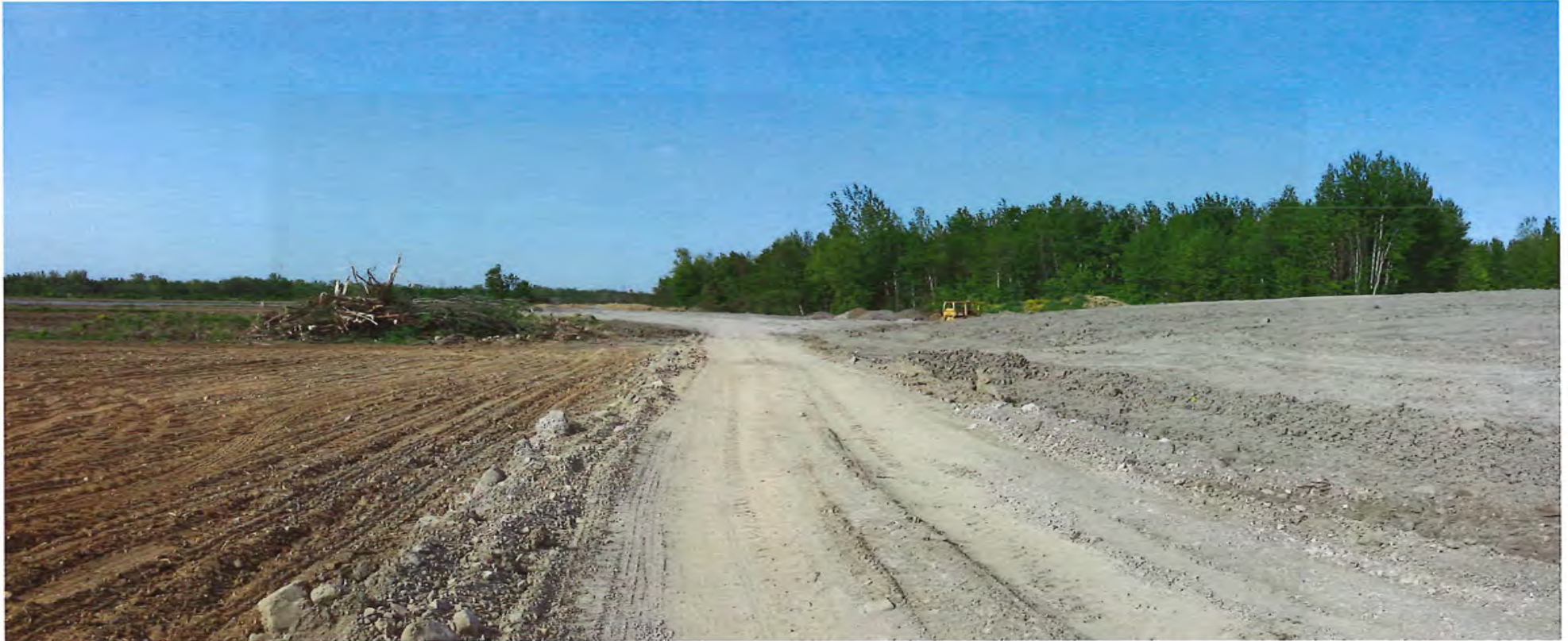
Photo 4 : Vue du chemin séparant la terre cultivée et le remblai
