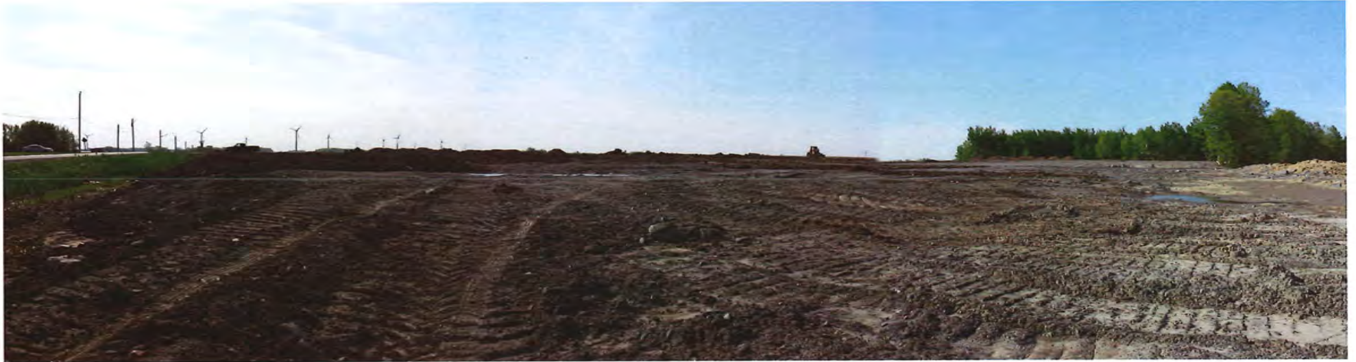
Photo 32 : Vue du coin nord-ouest
