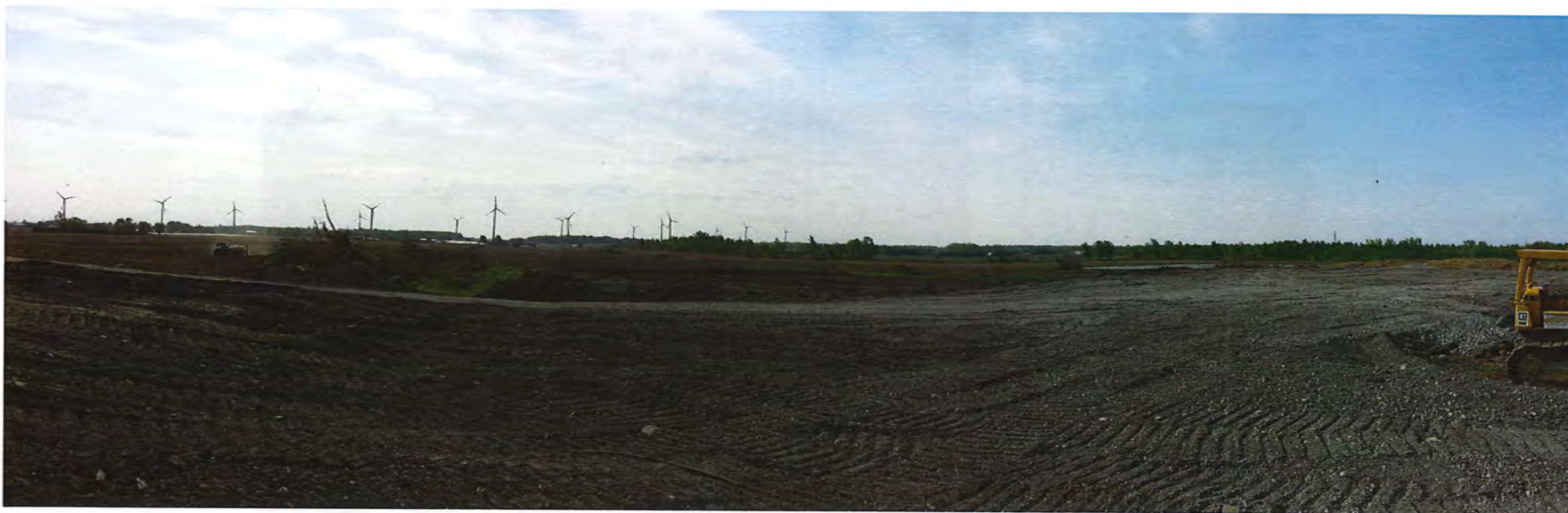
Photo 19 : Vue du remblai
