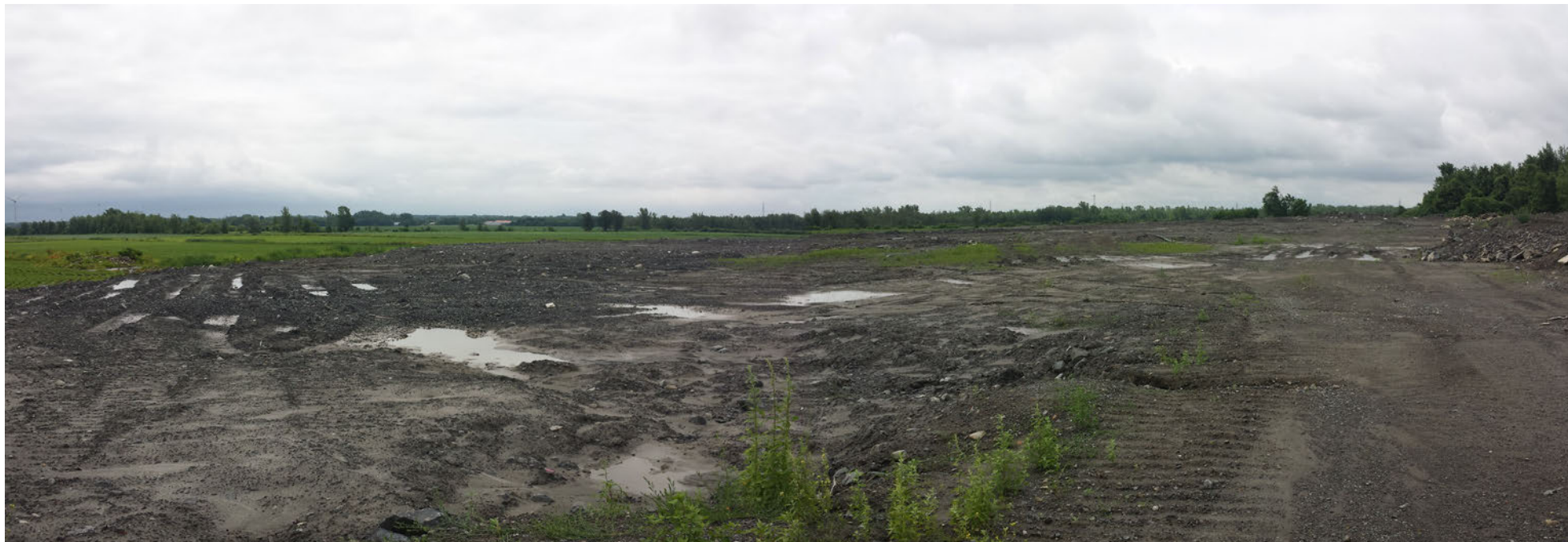
Photo 12 : Vue du remblai au sud de la tranchée.
