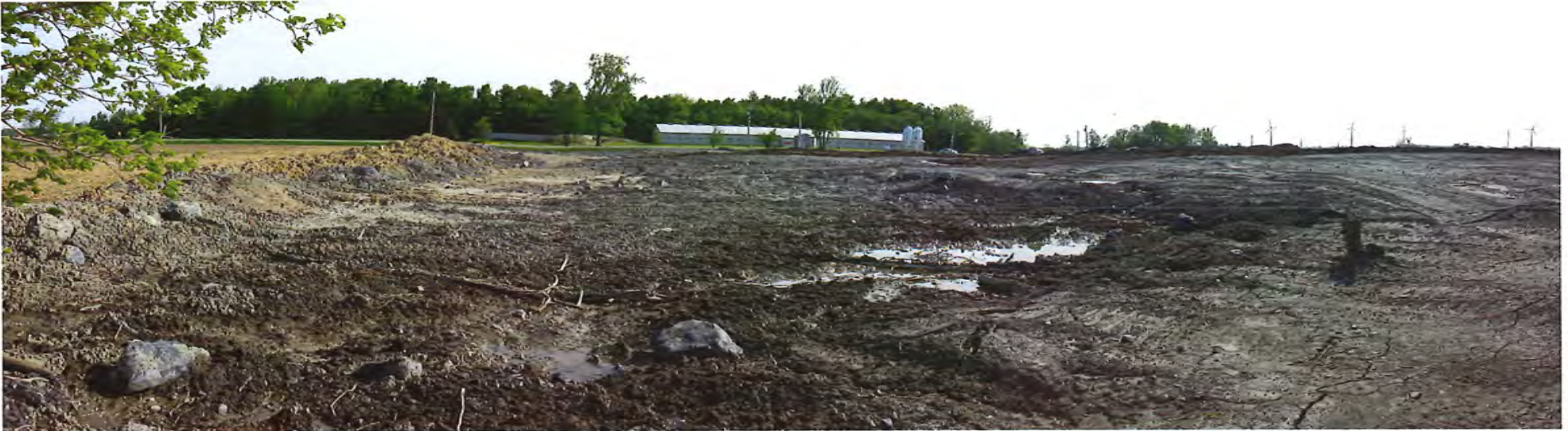
Photo 28 : Partie sèche du remblai
