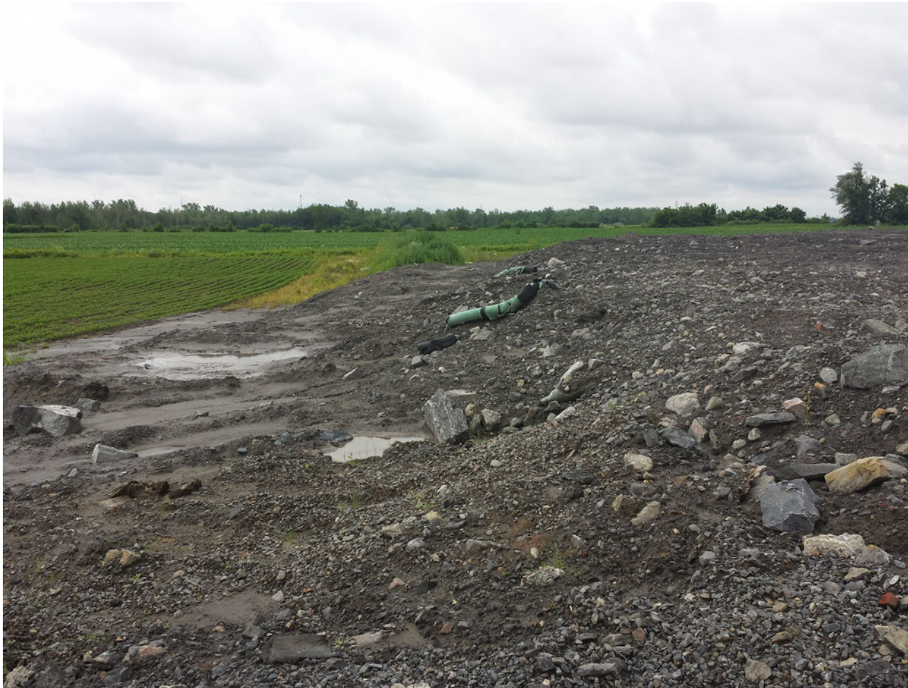
Photo 15 : Tuyaux dans le remblai.
