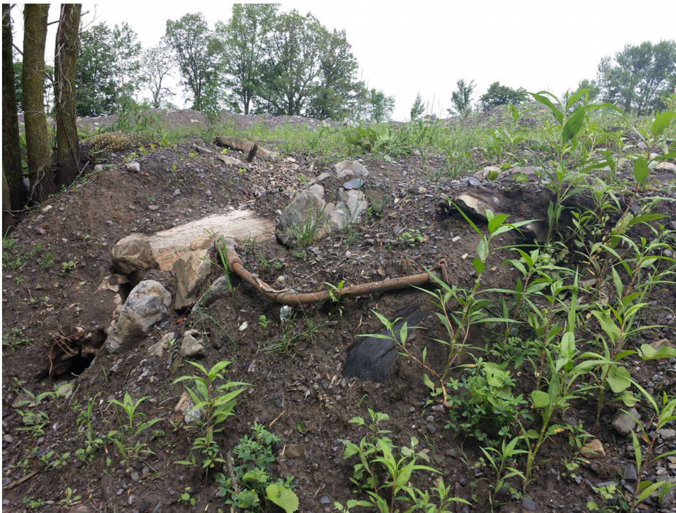
Photo 24 : Tuyau dans le remblai au nord de la tranchée.
