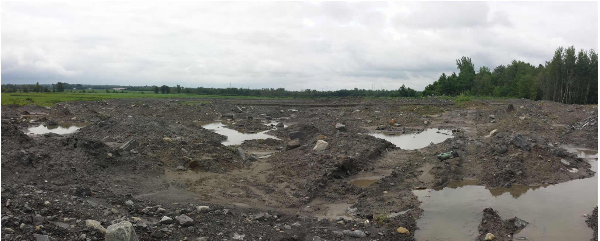
Photo 9 : Remblai, vue vers le sud.
