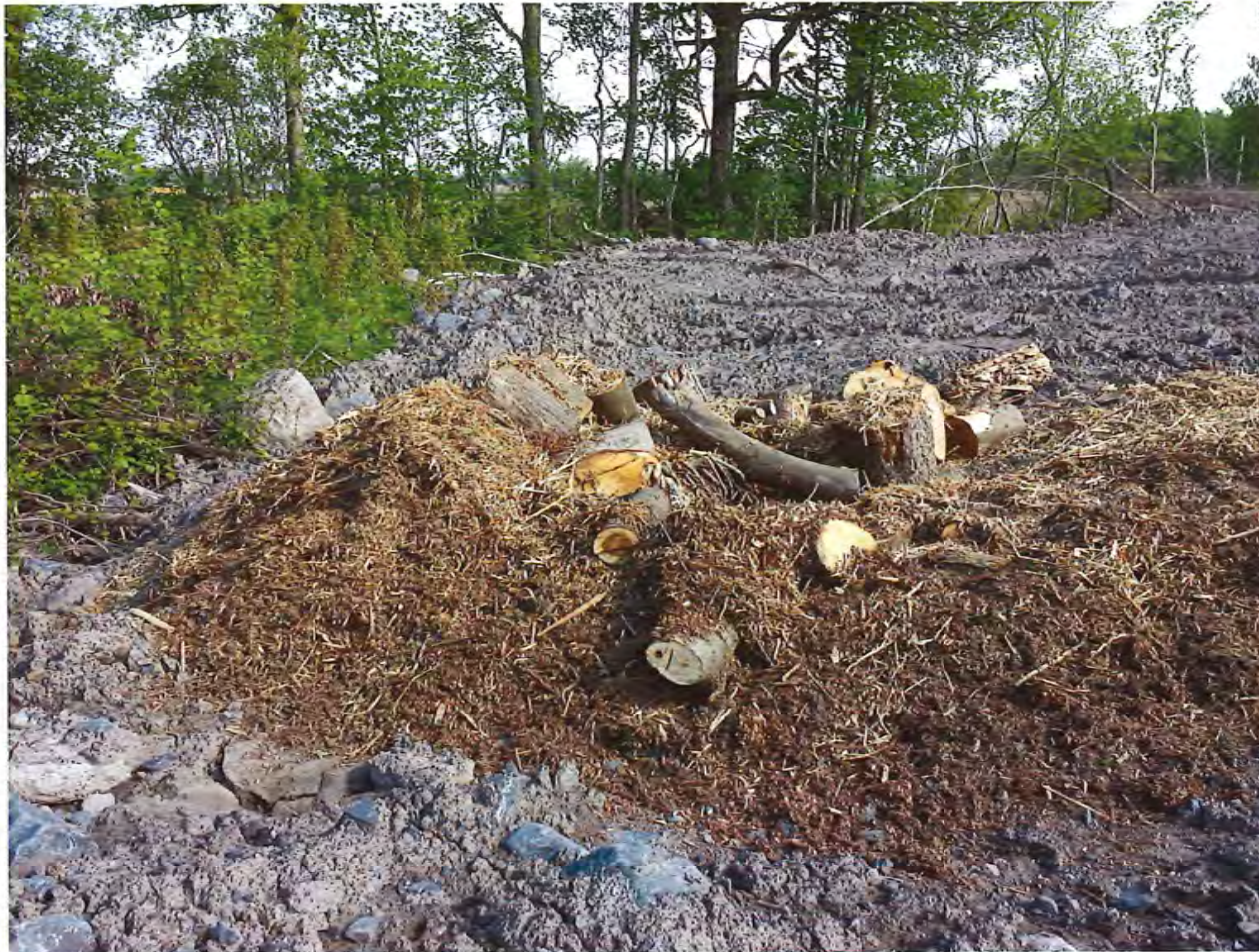
Photo 26 : Morceaux de bois et matières ligneuses sur le remblai
