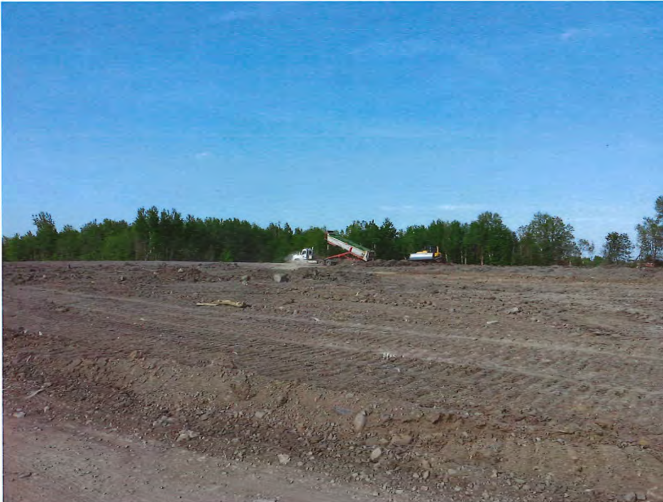
Photo 2 : Camion qui déverse sa cargaison
