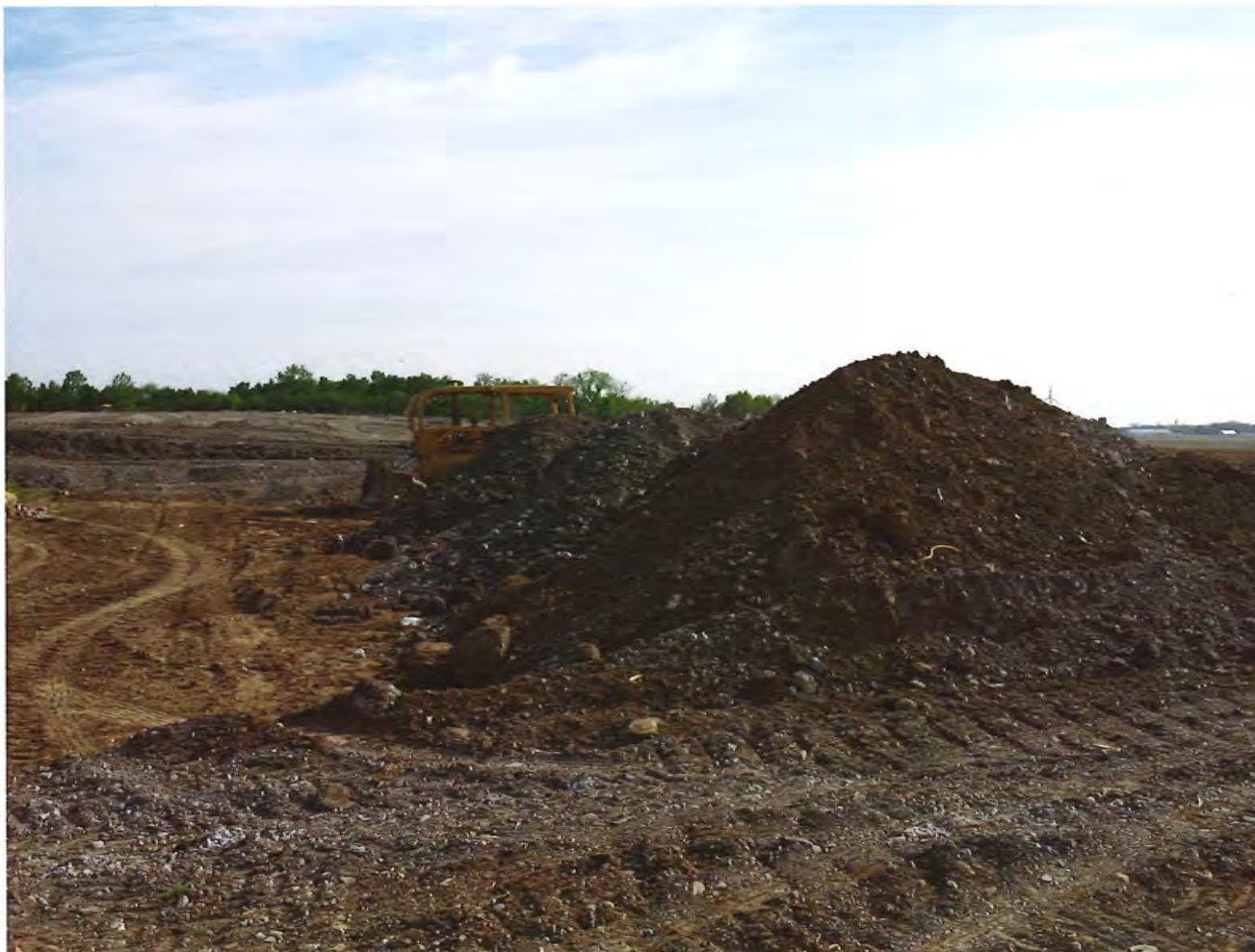
Photo 16 : Amas de terre près de la machinerie
