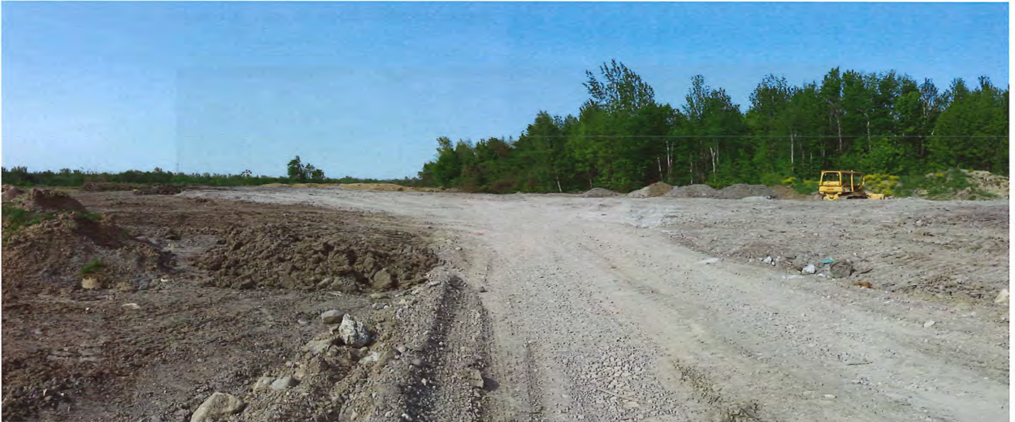
Photo 6 : Vue d'ensemble du remblai vers le lot 3 847 597
