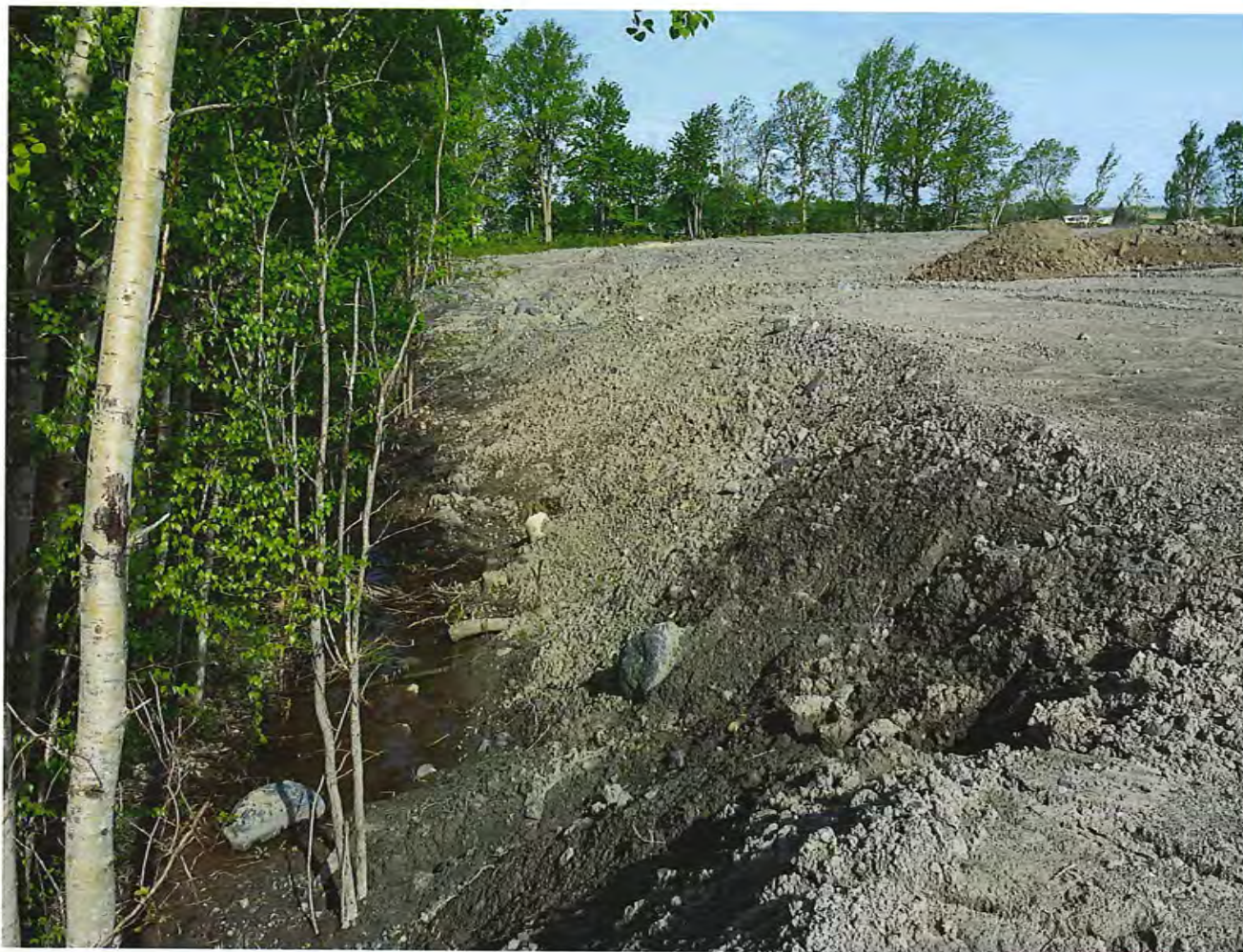
Photo 21 : Hauteur du remblai
