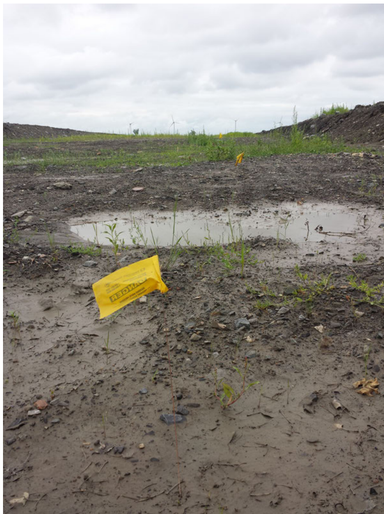
Photo 22 : Ligne de drapeau indicateur de ligne de gaz.
