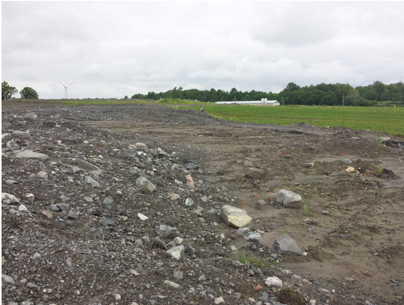
Photo 14 : Vue vers le nord.
