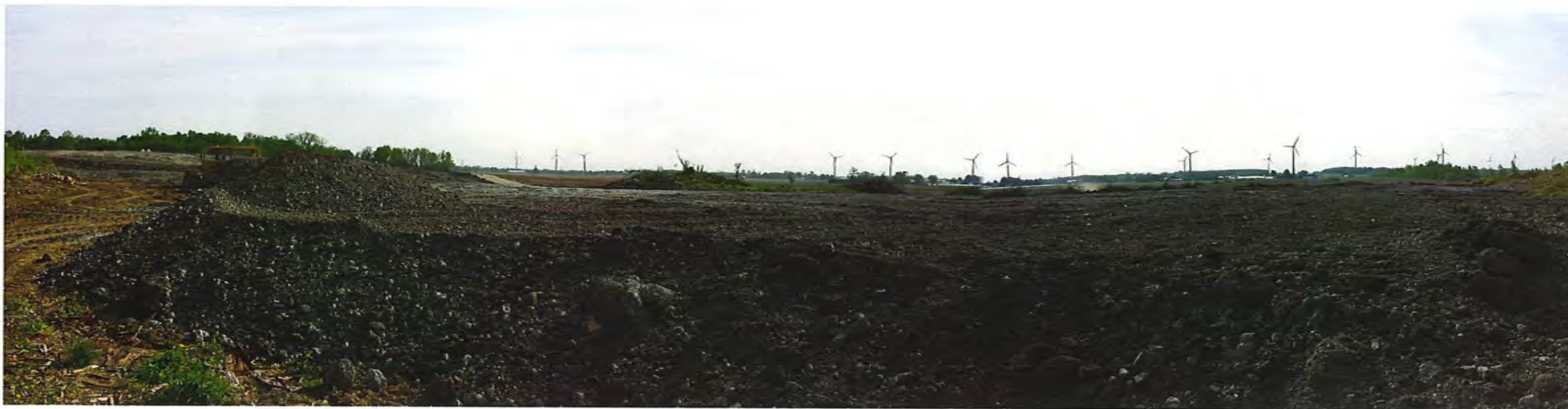
Photo 15 : Remblai sur le lot 3 847 597
