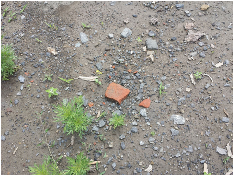
Photo 3 : Morceaux de briques dans le remblai.
