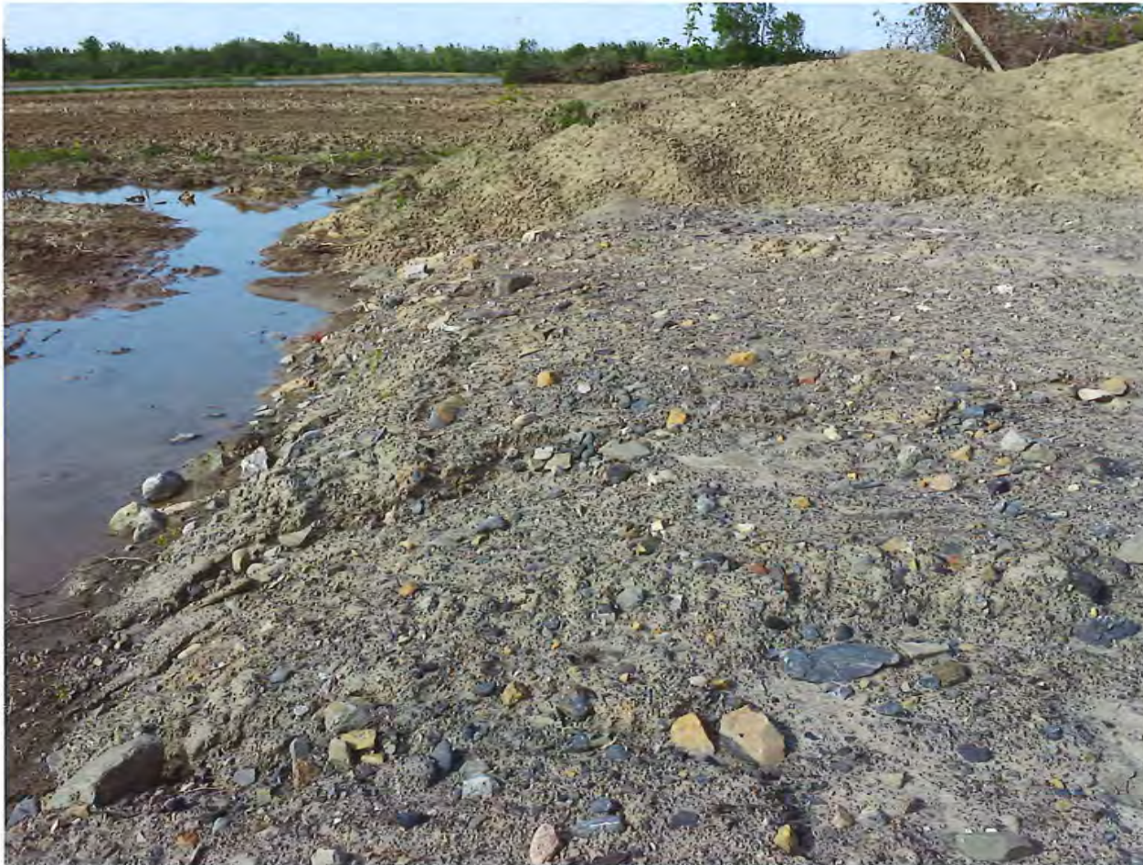
Photo 10 : Vue de la limite du remblai
