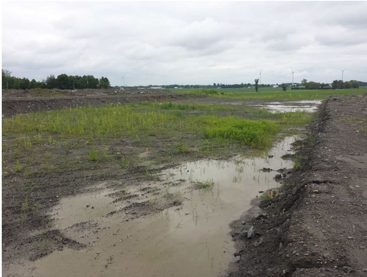
Photo 11 : Vue de la tranchée vers le champ (est).
