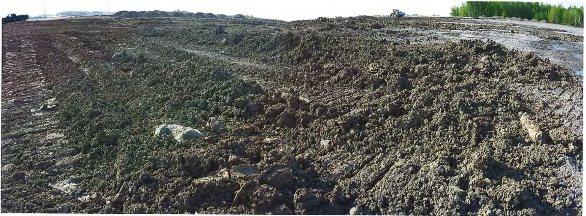
Photo 31 : Remblai vu de la limite nord-ouest
