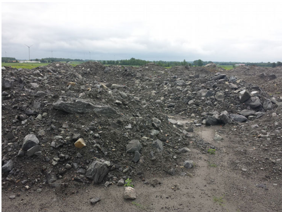
Photo 7 : Amas de remblai avec présence de roches.
