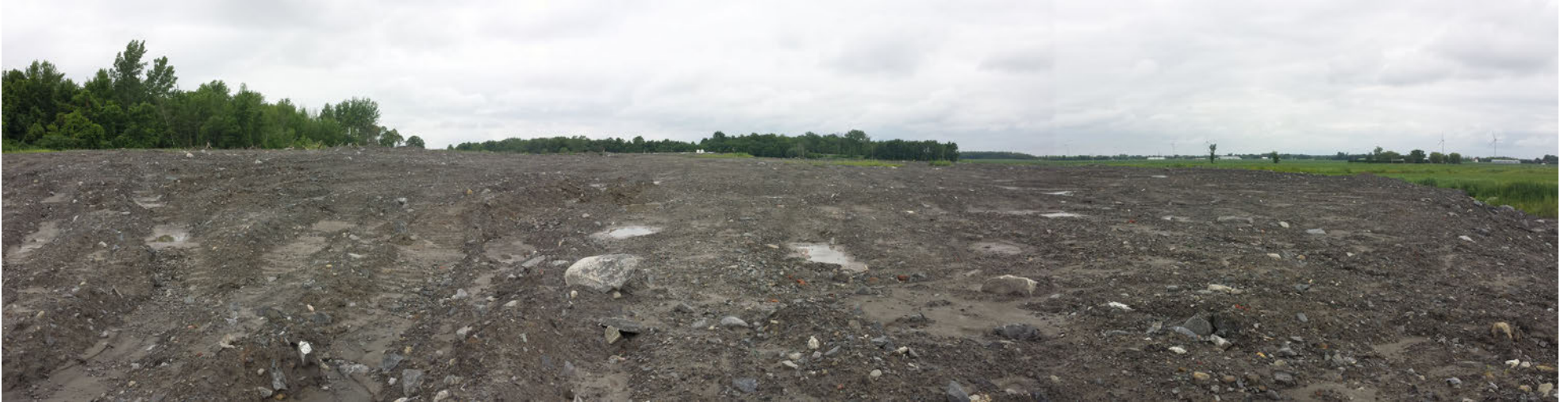
Photo 17 : Vue d'ensemble à partir de la limite sud.
