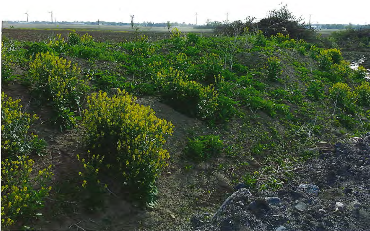
Photo 7 : Andain de sol arable mis de côté pour étendre après les travaux
