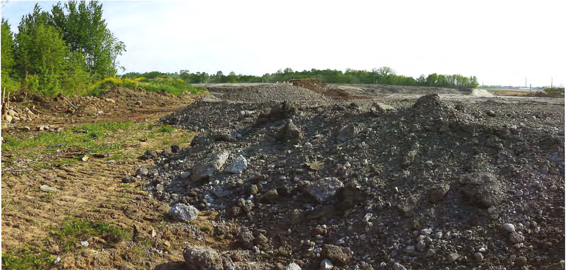
Photo 14 : Remblai par rapport au niveau du sol
