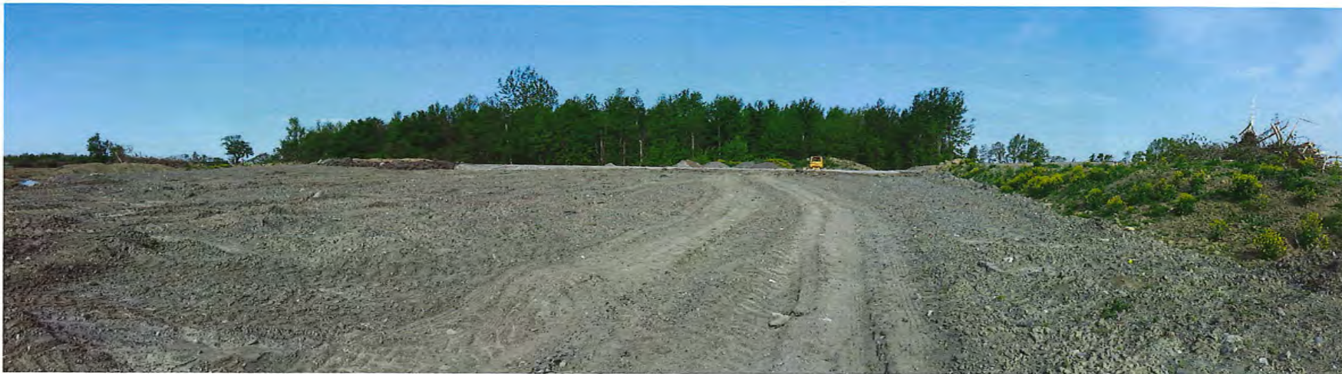
Photo 9 : Vue du remblai sur le lot 3 847 594
