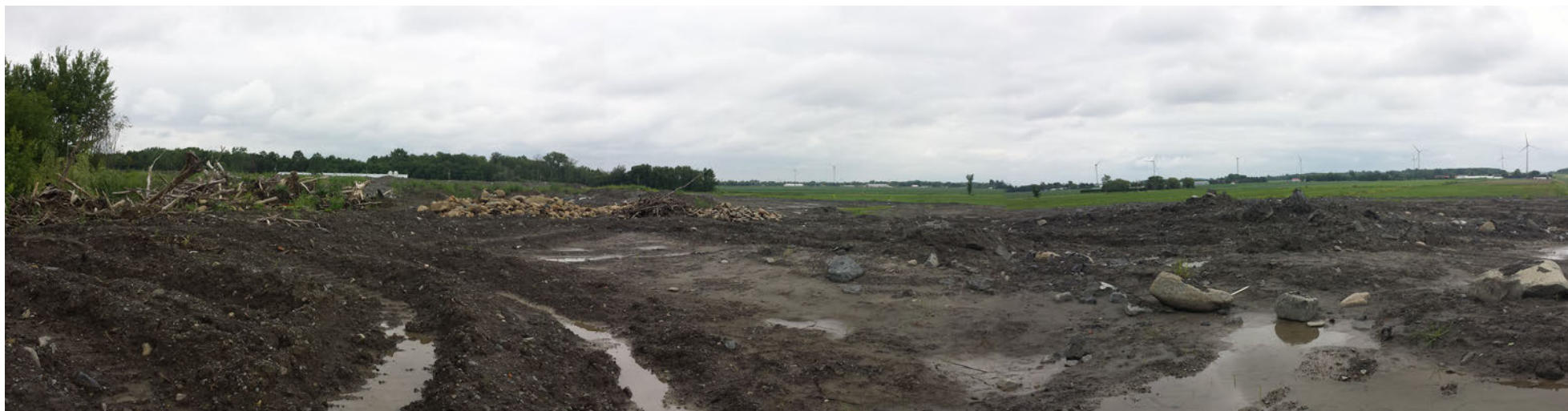
Photo 18 : Vue du remblai vers la tranchée.
