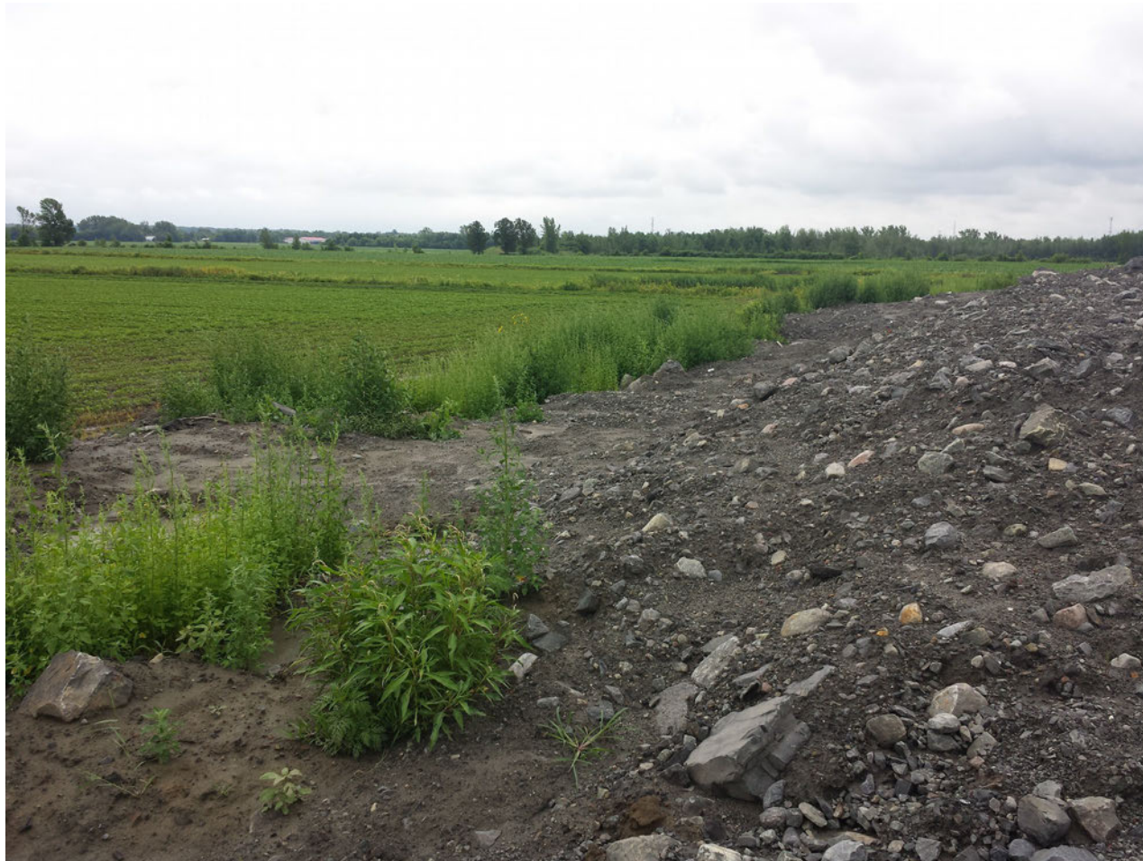
Photo 13 : Hauteur du remblai au sud-est.
