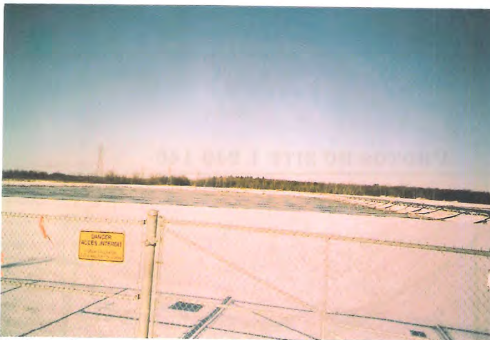
Photo 1 : Étangs aérés de la Régie des eaux usées de Lachenaie – Mascouche.
