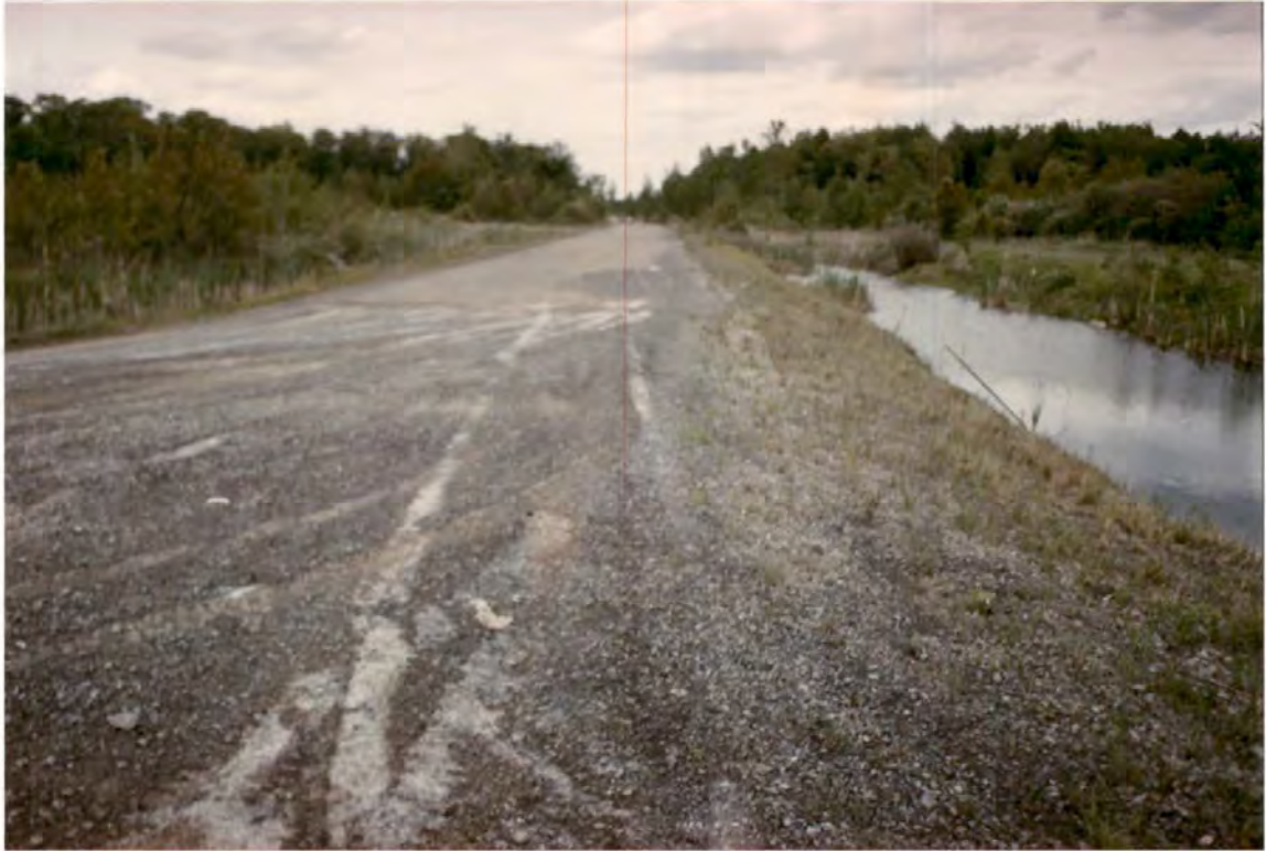
23- Vue du chemin privé (lot 48-2) donnant accès à la carrière à partir du rang St-Rémi. Ce chemin est pavé.
