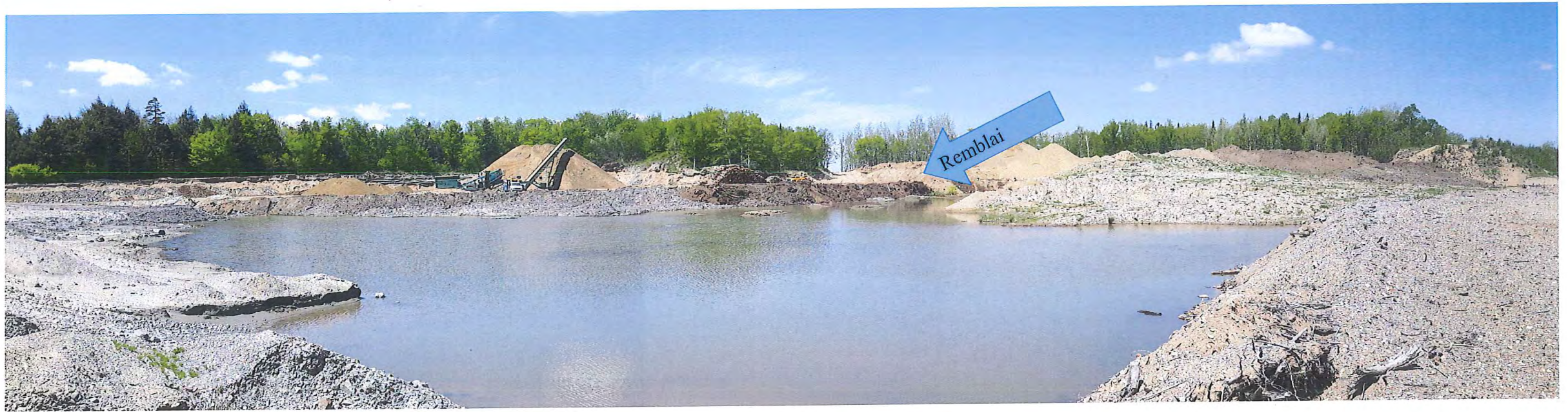
Photo 2. Vue nord-ouest de la partie de l'exploitation en dessous du niveau de la nappe.
