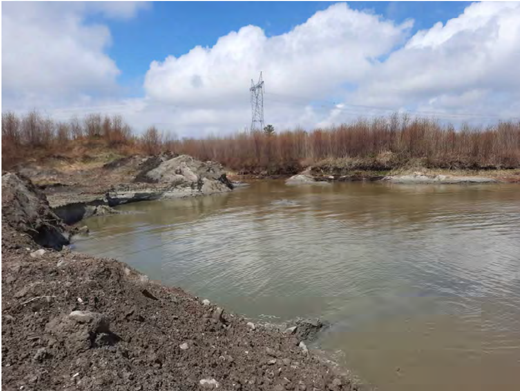
Photo 3. Exploitation effectuée sous le niveau de la nappe phréatique
