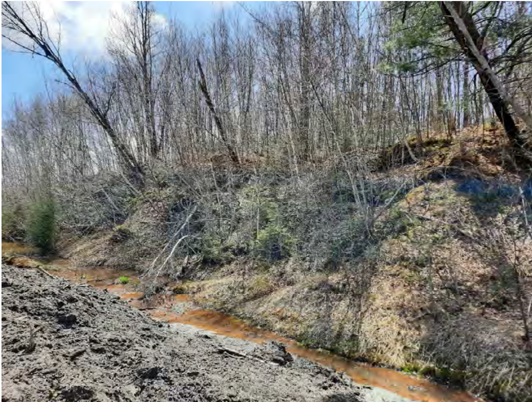
Photo 7. Limite Ouest où un talus a mal été aménagé et les arbres tombent.
