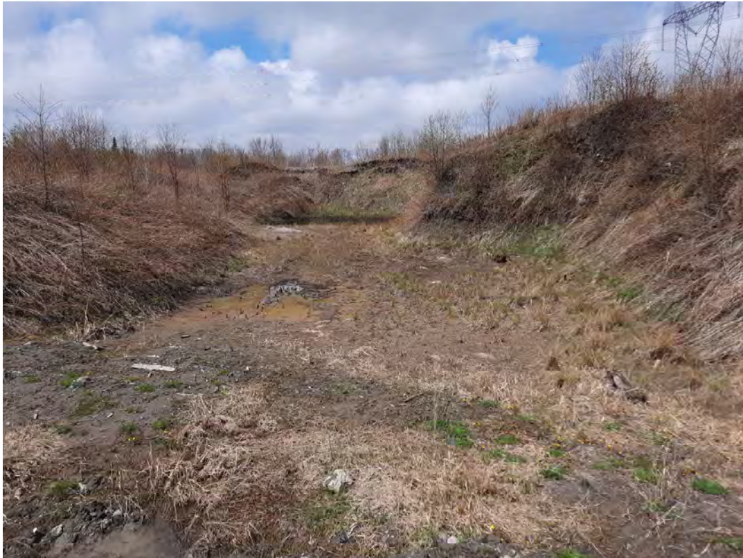
Photo 4. Exploitation laissant des talus avec une pente trop abrupte et un sol humide, de part la proximité avec la nappe phréatique.
