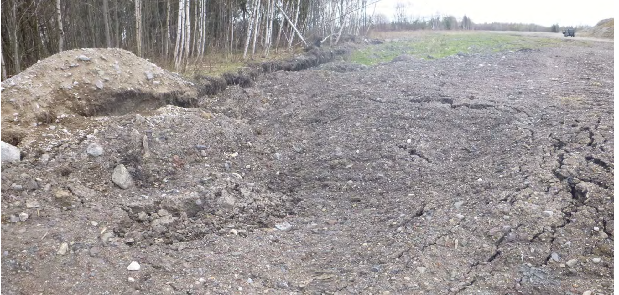
Vue de la limite Sud du remblai effectué
