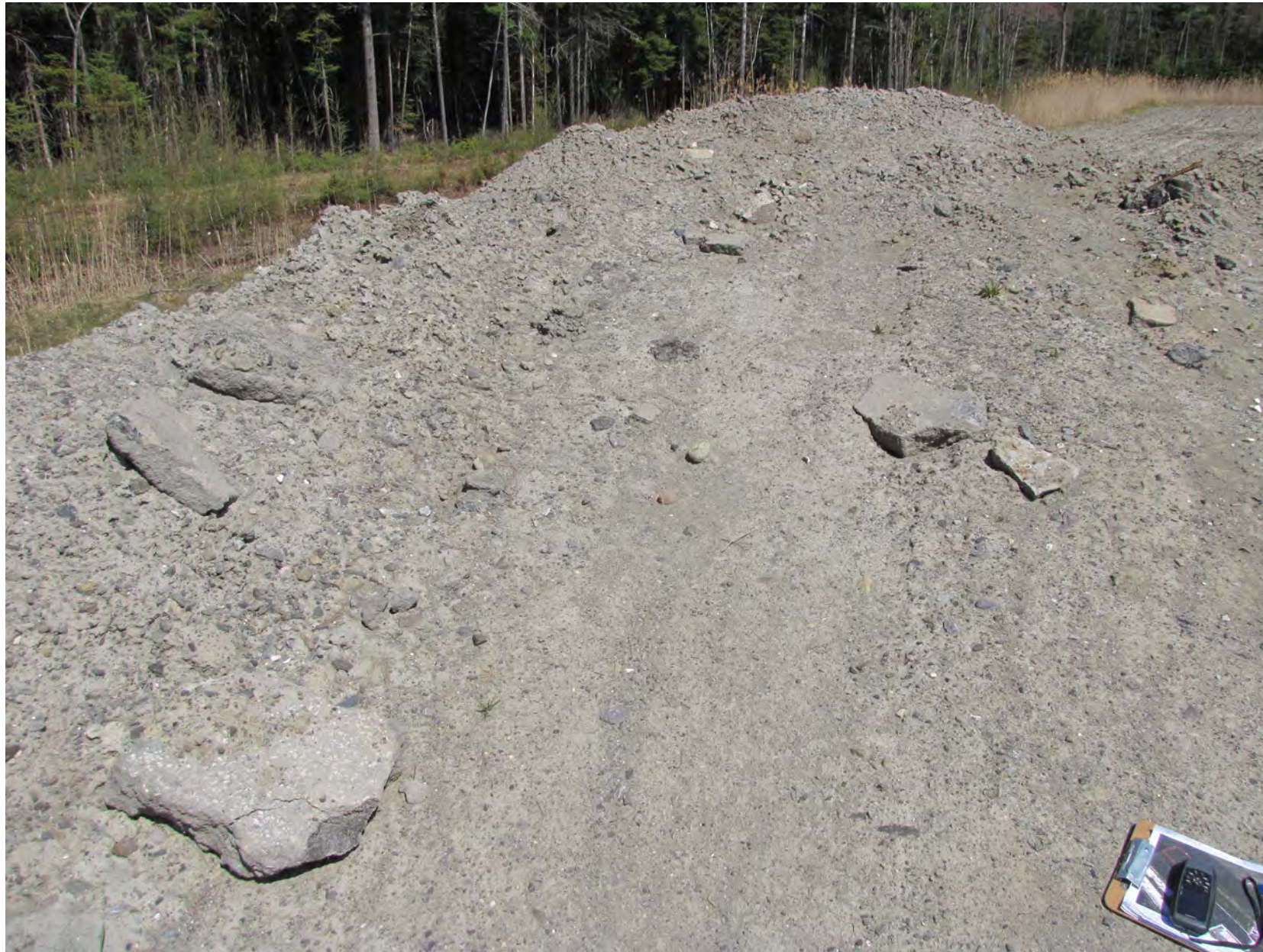
Amas de matériel comprenant de l'asphalte dans la zone 2.
