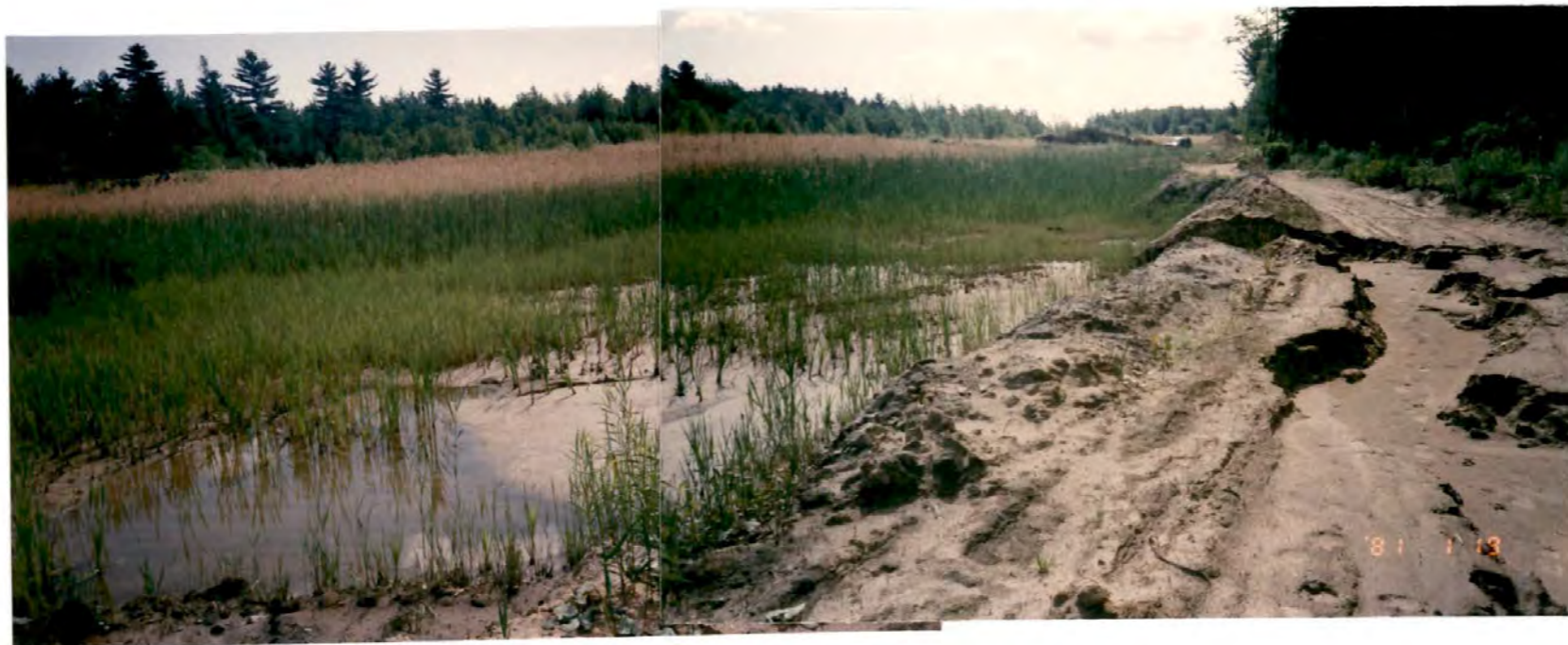
↑ Vue au centre du lot
