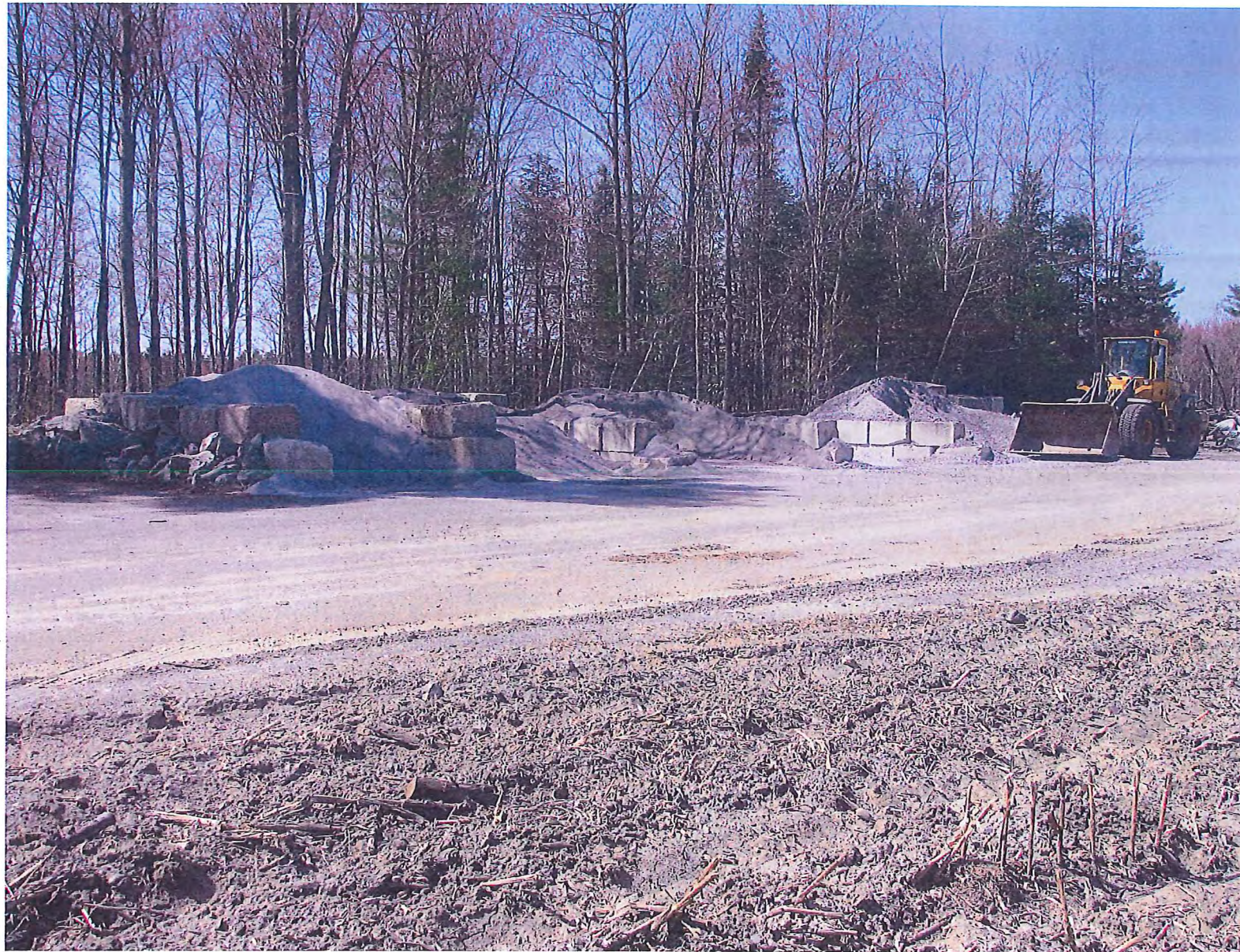
Entreposage de matériaux granulaires (zone 3).
