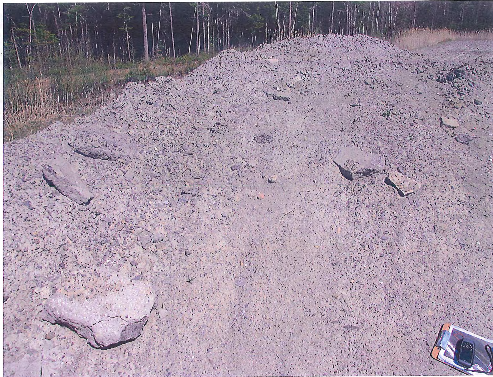
Amas de matériel comprenant de l'asphalte dans la zone 2.
