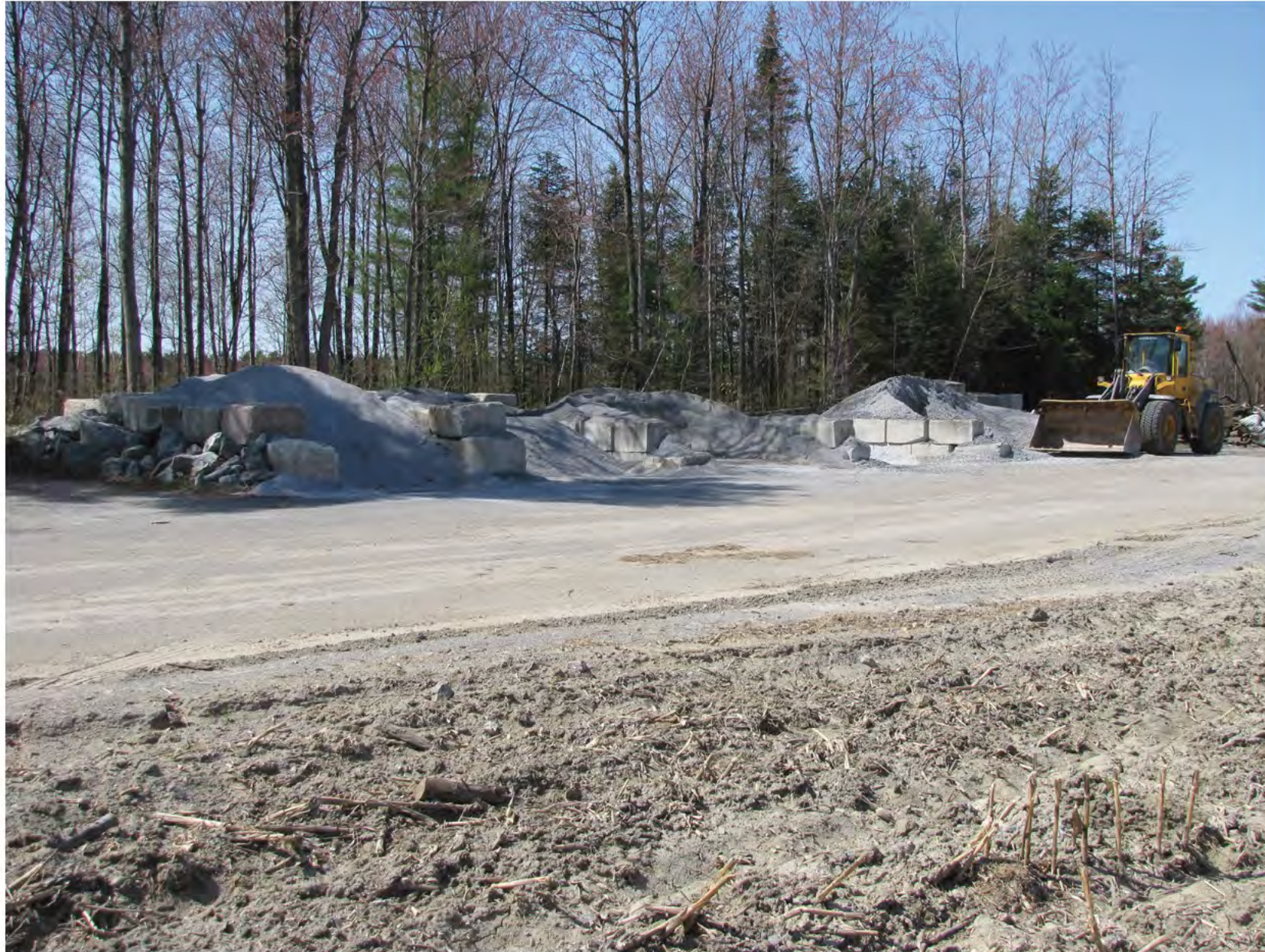
Entreposage de matériaux granulaires (zone 3).
