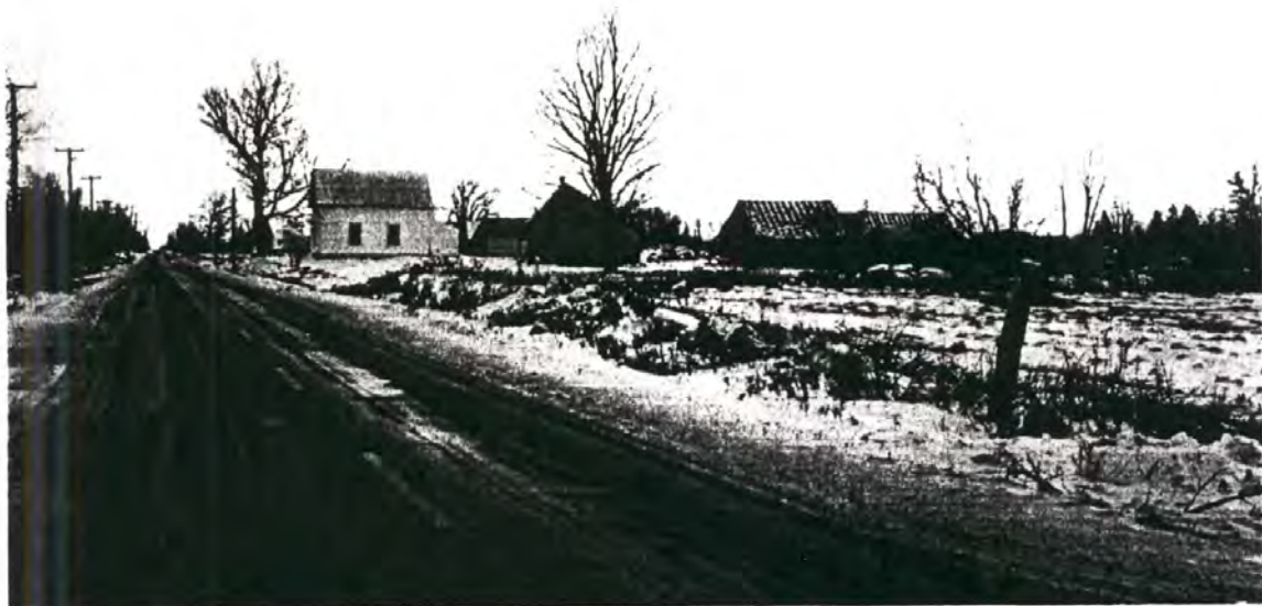
10- Vue, en direction sud-est, du chemin Côte St-Louis à la hauteur du lot 68-2 étudié. On aperçoit, à droite du chemin, une maison et quelques vieux bâtiments de ferme désaffectés.
