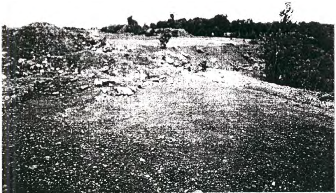
21- Secteurs remblayés avec de la pierre concassée au nord-est de la carrière.
