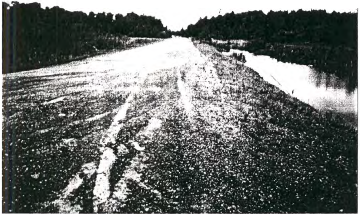
23- Vue du chemin privé (lot 48-2) donnant accès à la carrière à partir du rang St-Rémi. Ce chemin est pavé.
