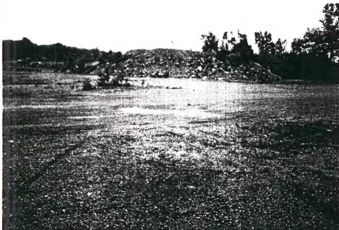
20- Secteurs remblayés avec de la pierre concassée au nord-est de la carrière.
