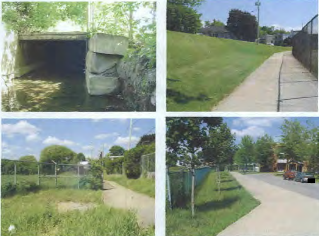
Figures 29 à 32. Parcours de la canalisation entre les rues Loyola et Anne-Mayrand. (Crédits CAGEQ)
