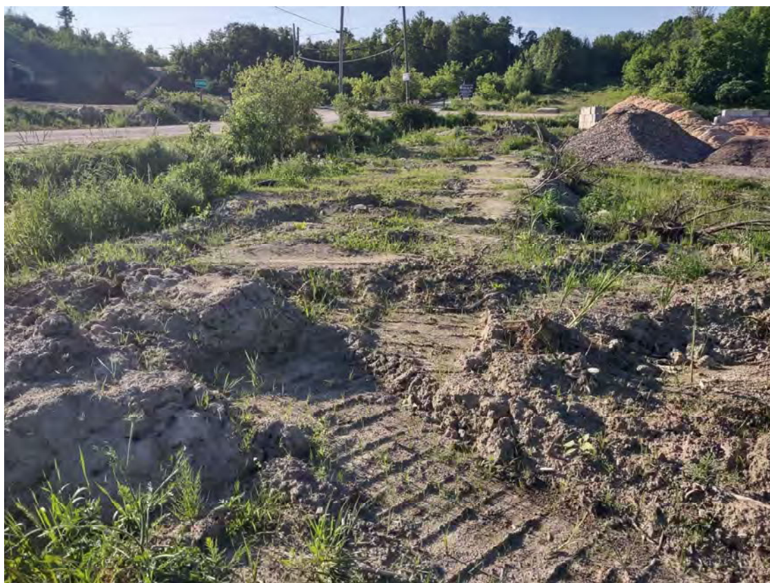
Photo 7. Bande de protection de 5 m à l'est du fossé (côté nord du chemin d'accès)
