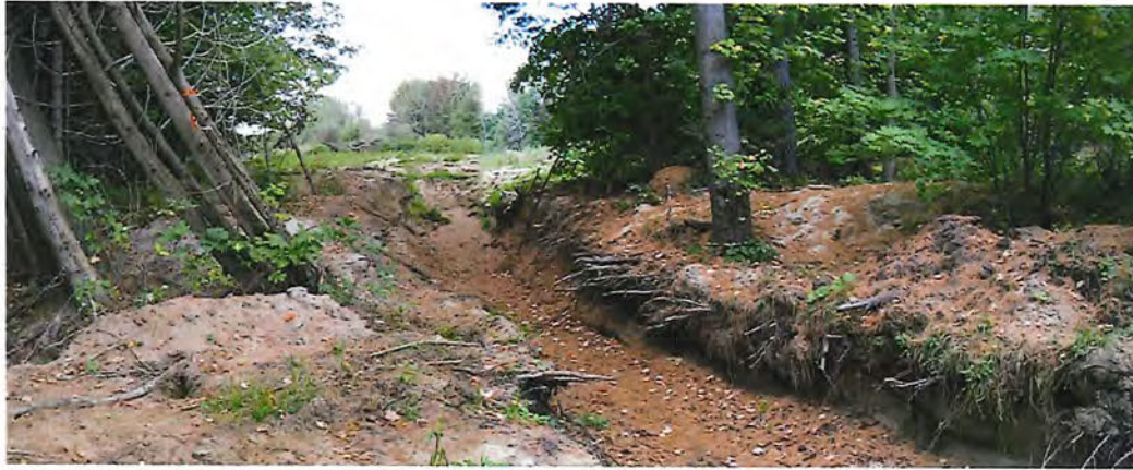
7. Vue du fossé excavé du coin sud-est vers le sud pour drainé le secteur sud-est (D.L. 04-10-2017)
