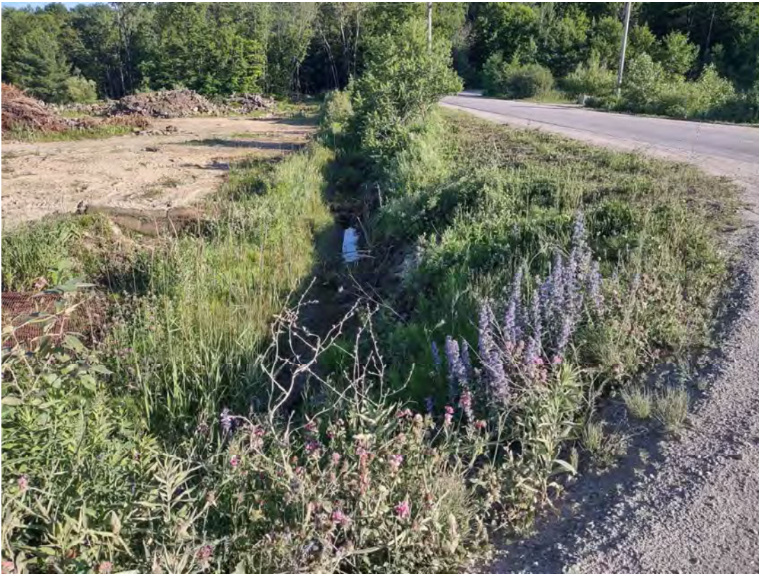
Photo 8. Fossé sur le côté sud du chemin d'accès
