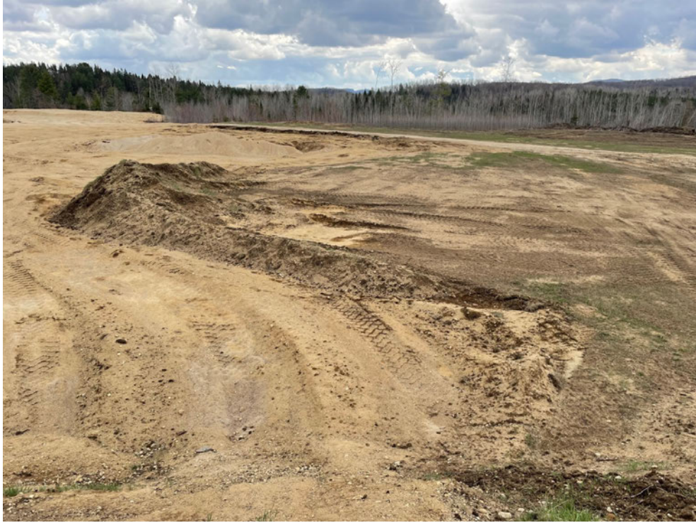
Photographie 6 (réf. 5920) Secteur décapé à gauche et non décapé à droite
