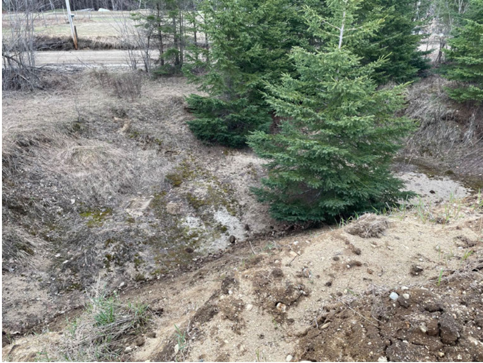
Photographie 4 (réf. 5918 - GPS987) Excavation à moins de 20 m du chemin
