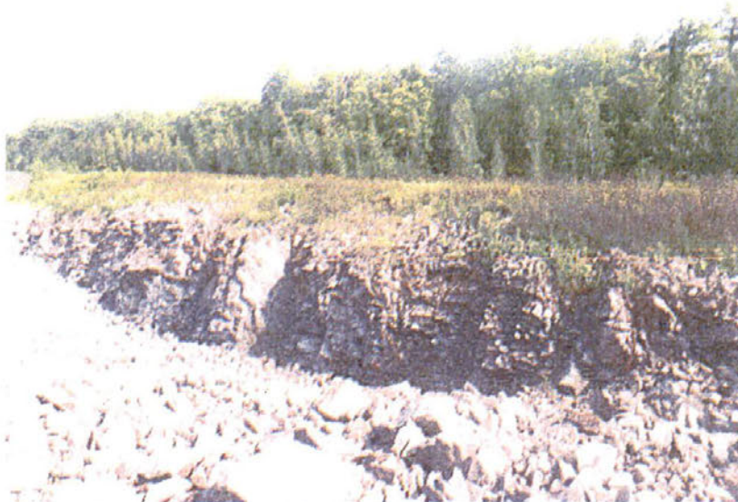
Photo : paroi sud de la carrière (vue vers le sud-est)
