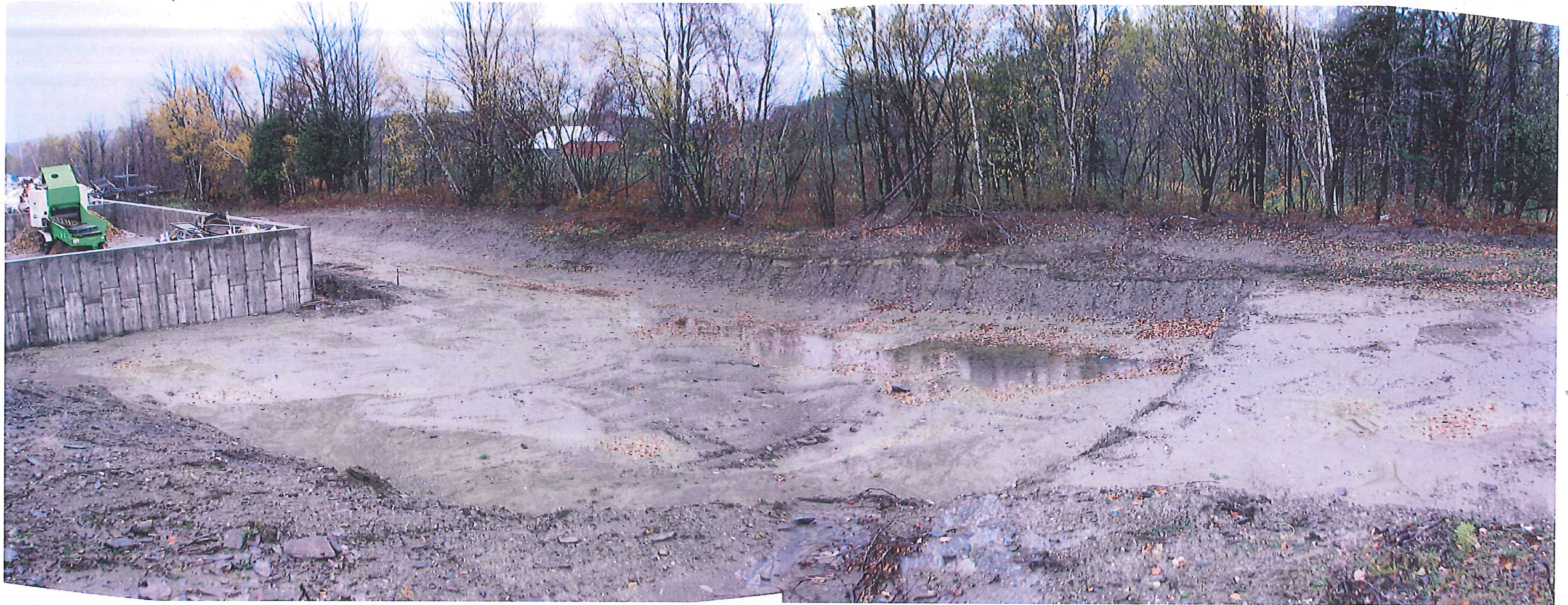
Limite nord-ouest de l'aire exploitée (récemment excavée pour le coulage de la dalle.)
