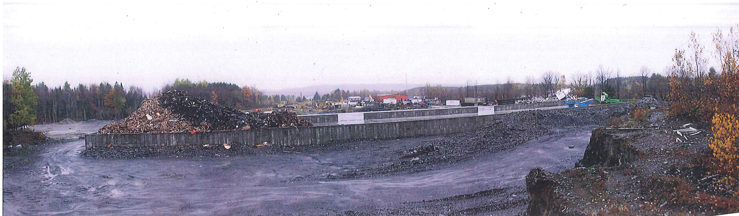
Vue générale dalle de triage, axe nord-nord-est / sud-sud-ouest.
