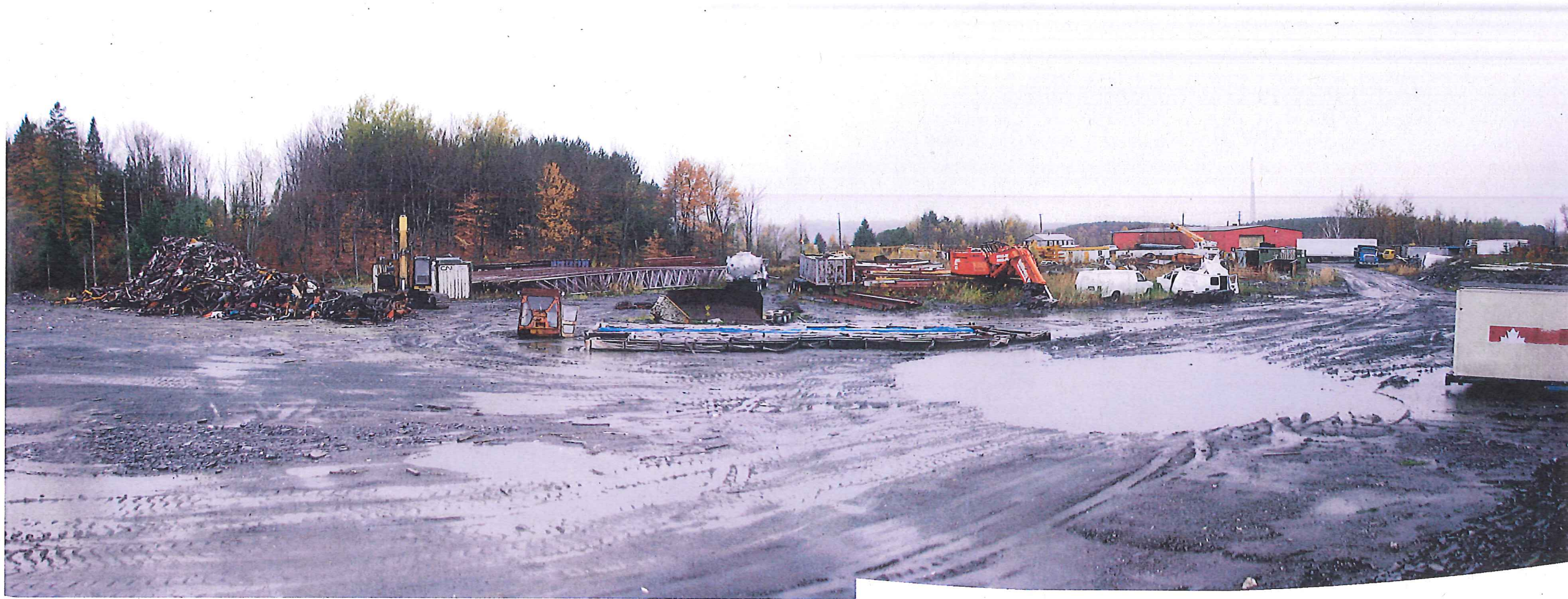
Vue générale, à partir de la dalle de tri, axe nord-sud.
