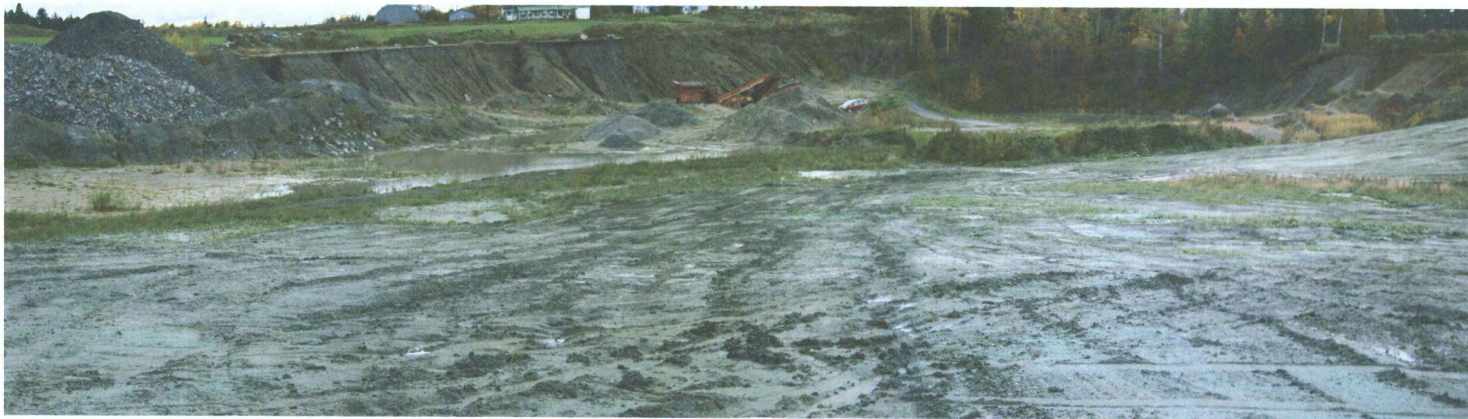
4 Partie réaménagée et ensemençé (direction nord-ouest) . .
