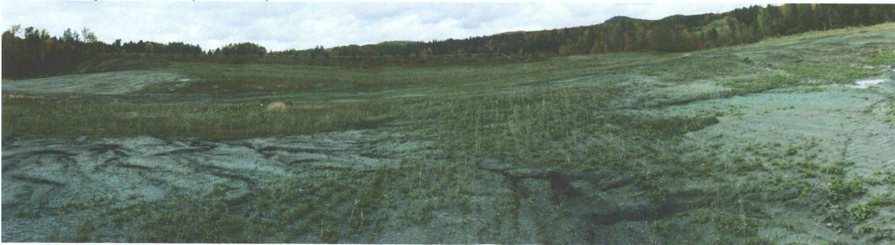
6 Vue d'érosion mineure localisée au haut de la pente (direction sud-est) .
