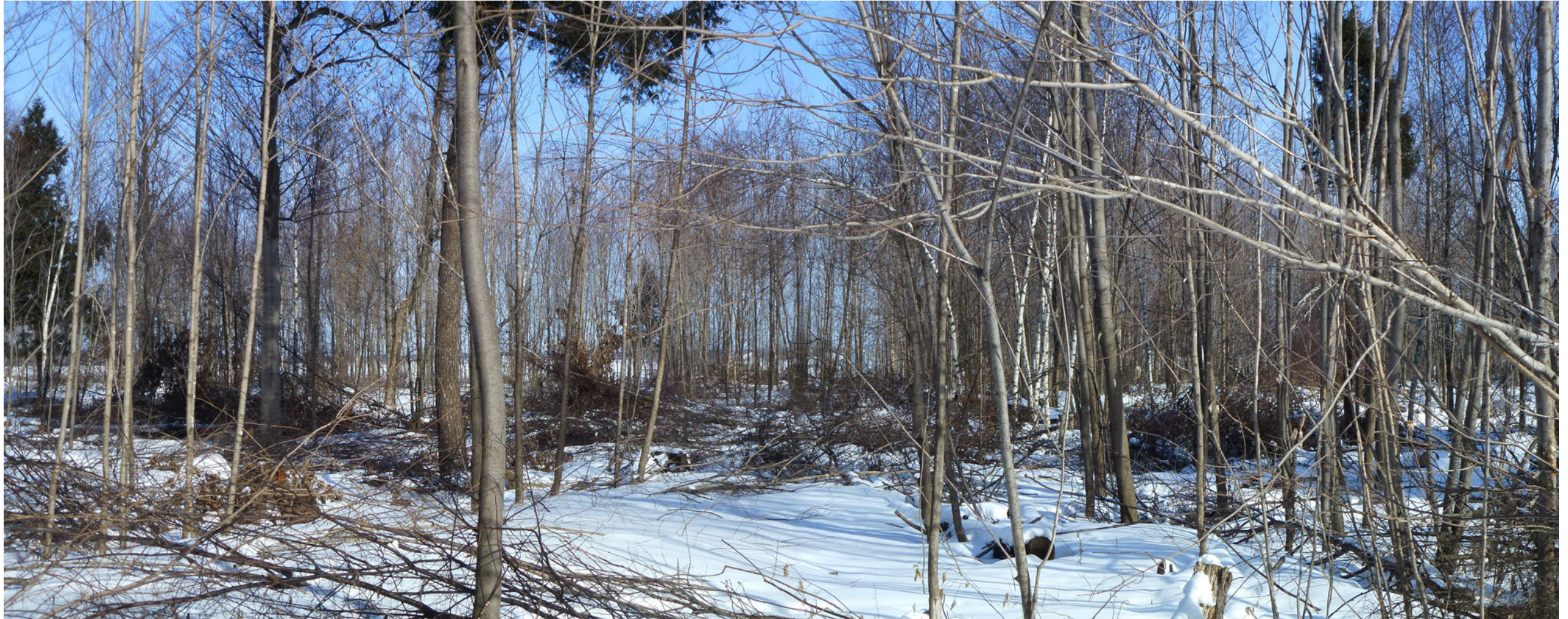
VUE DE L'ÉRABLIÈRE VERS LE SUD-EST : TRAVAUX DE NETTOYAGE
