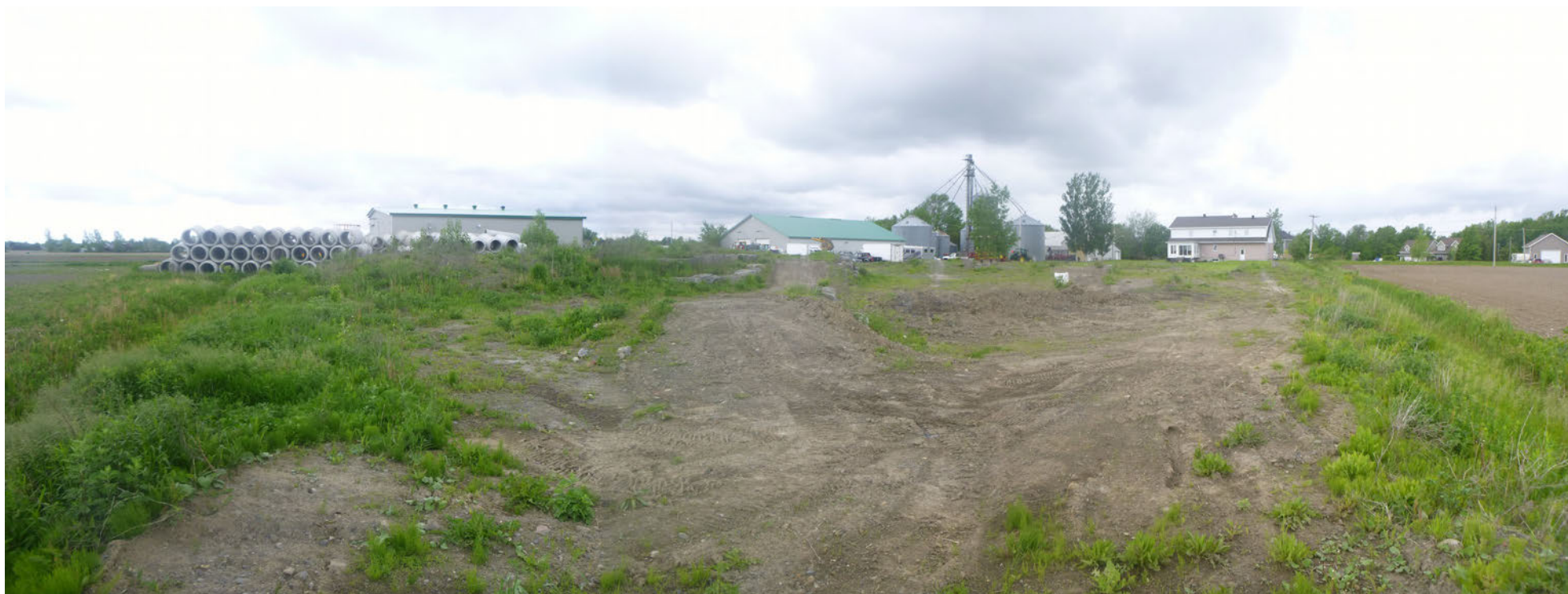
Photo 4 : Vue du coin sud-est.
