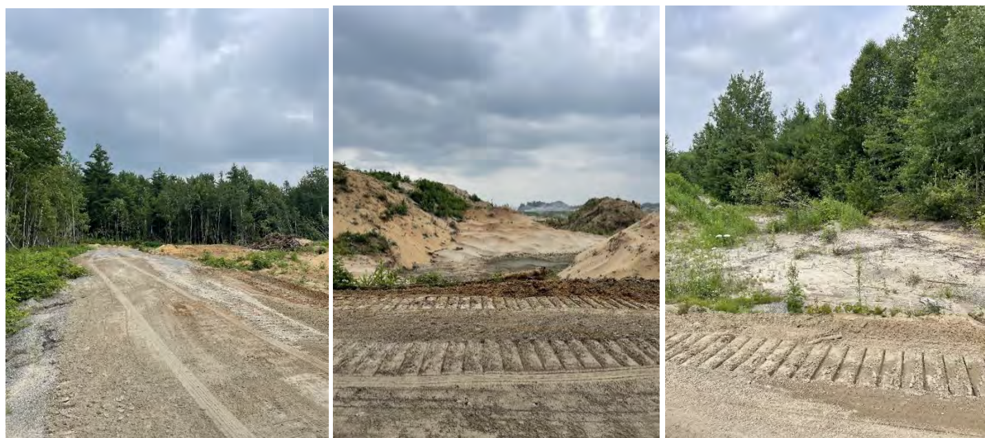
Photographie 40-41-42 : Aperçu du chemin d'accès vis-à-vis du point 13
