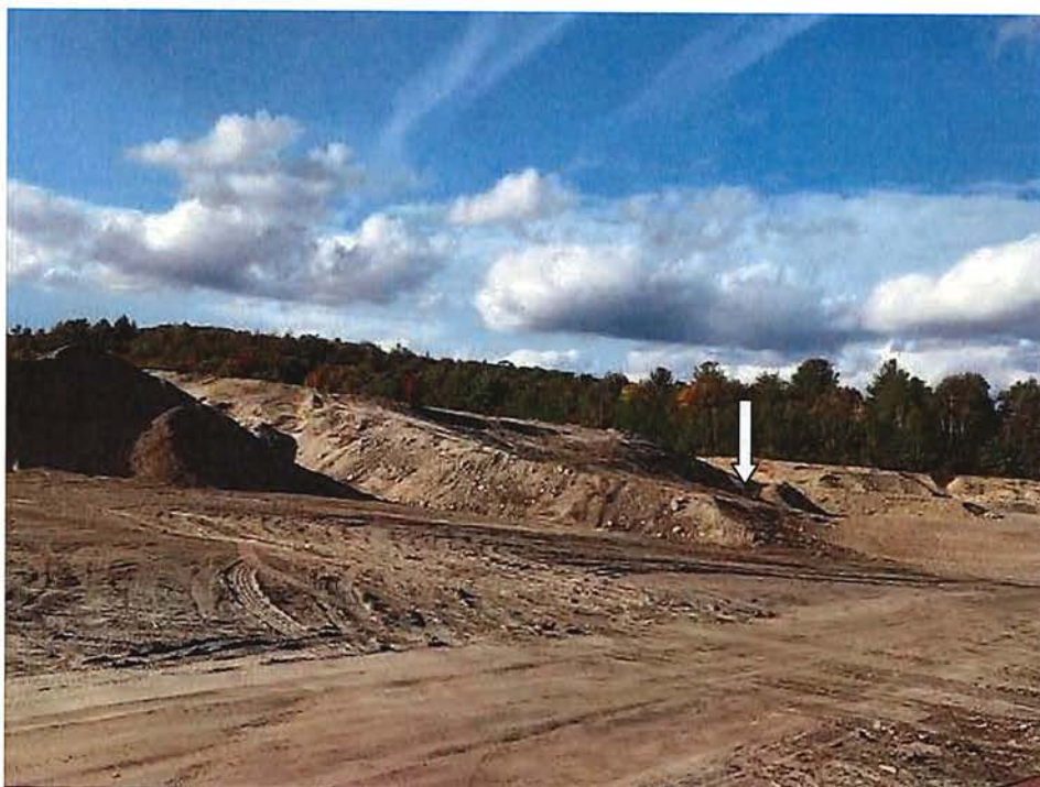
Photographie 5 (réf 6894) Espace dégagée en bordure de la Montée Jackson, reste une section de matériel à retirer
