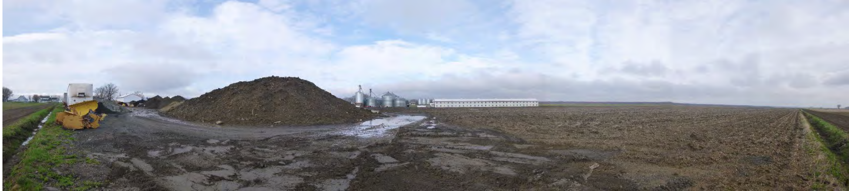
Photo 12 : Matériaux et reste du lot. (Collage de 5 photos).
