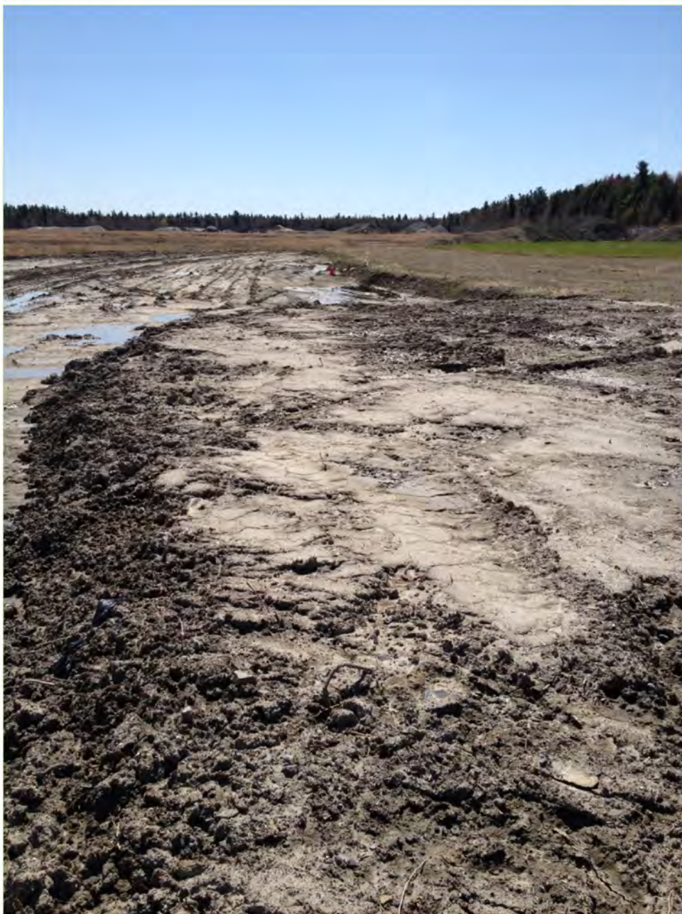
Travaux de remblai.
