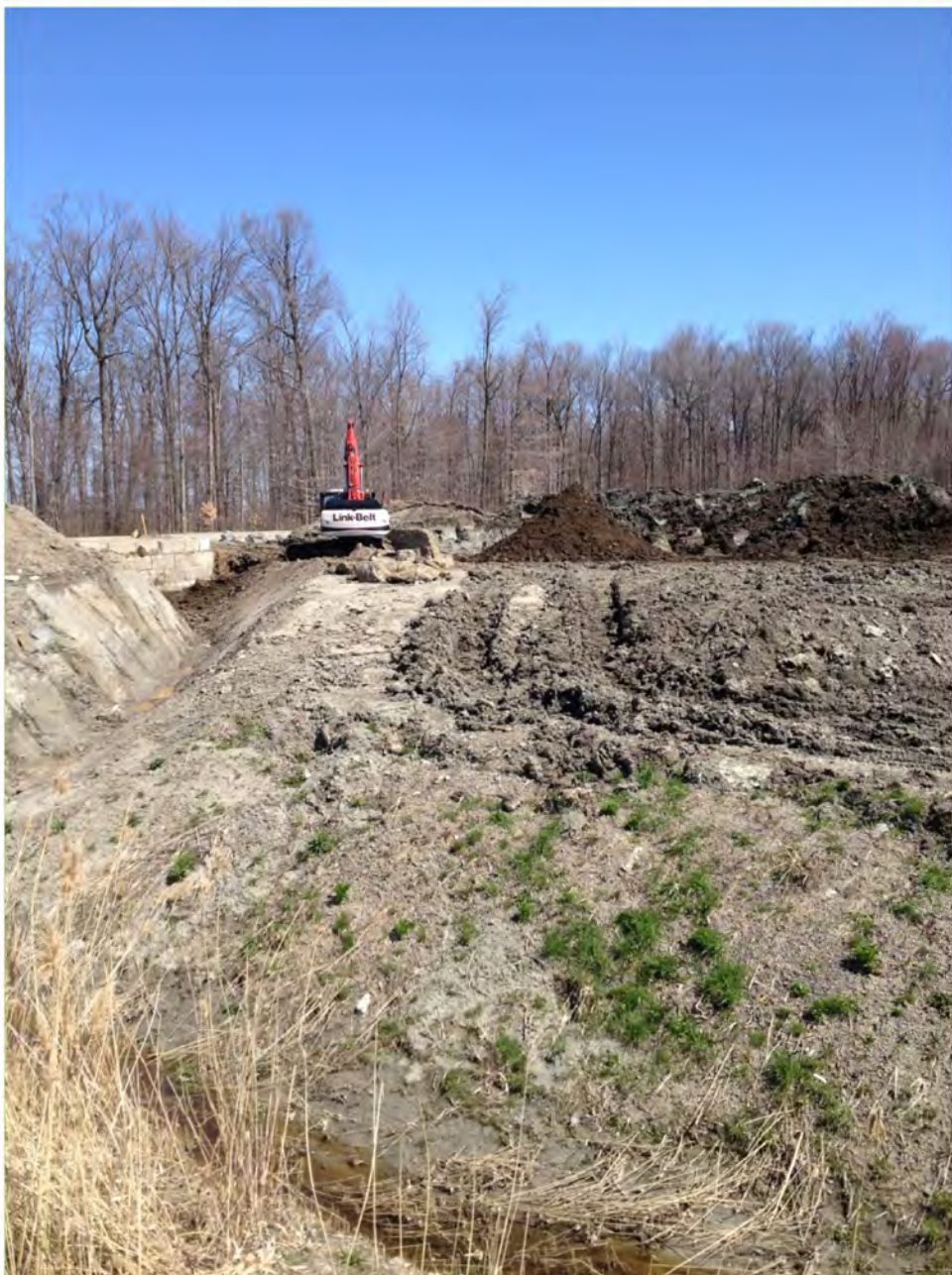
Zone des travaux de remblai. On accorde une grande importance à la qualité des matériaux qui entrent sur le site.
