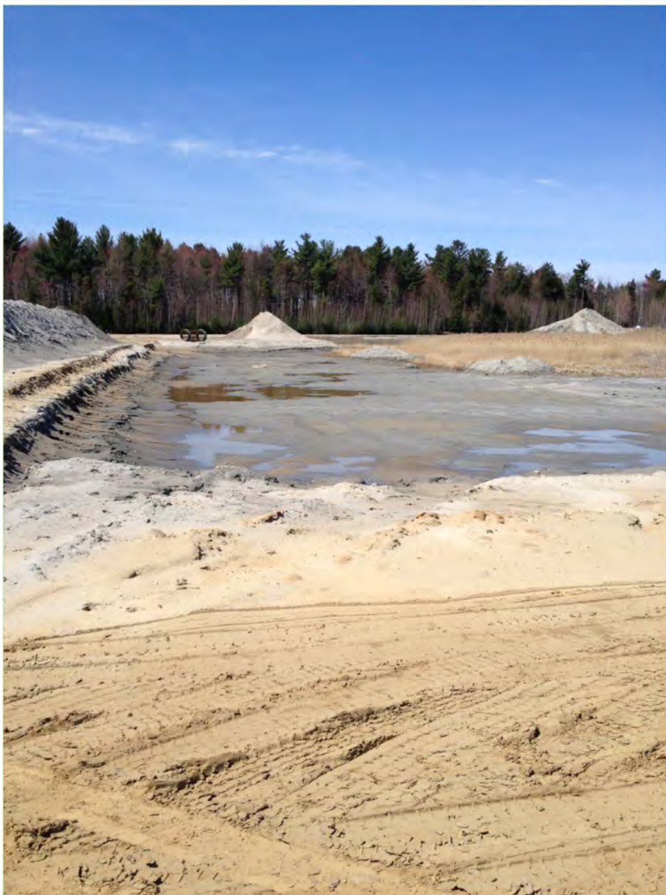
Front d'exploitation de la sablière.
