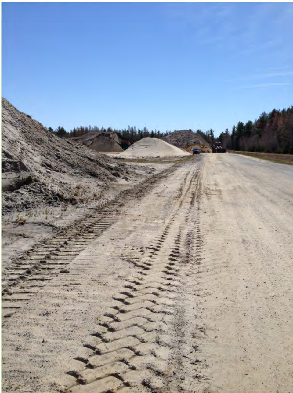
Chemin d'accès avec au fond la zone de préparation de terreau et l'accès à la zone d'exploitation de la sablière.
