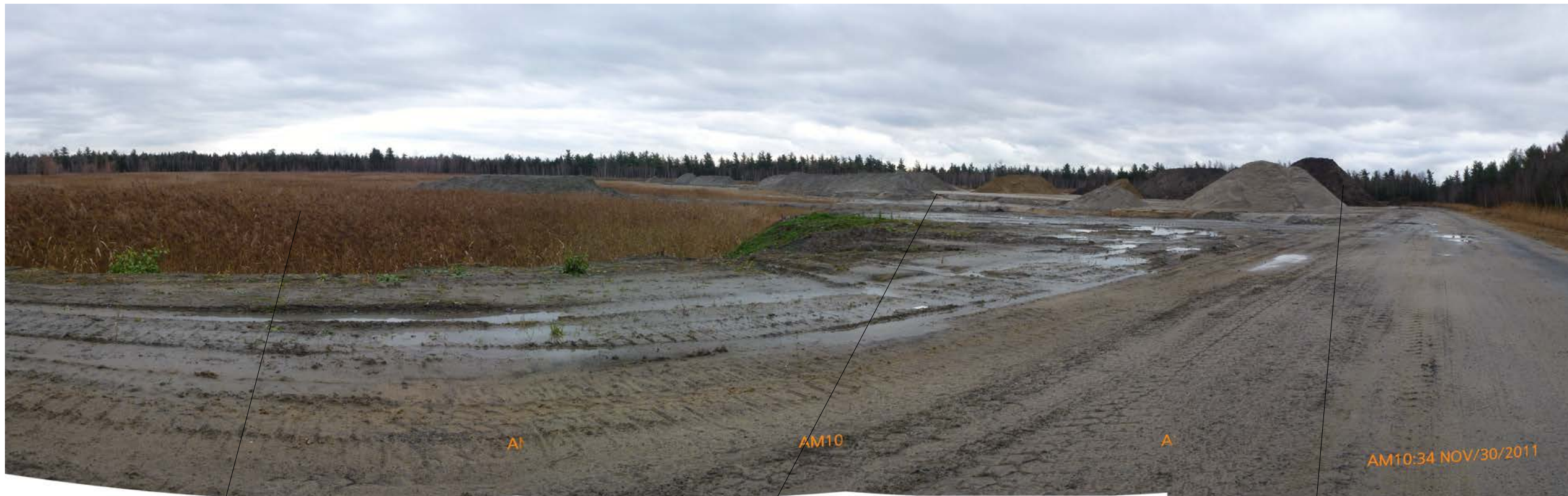
Plancher de la sablière, à remblayer
