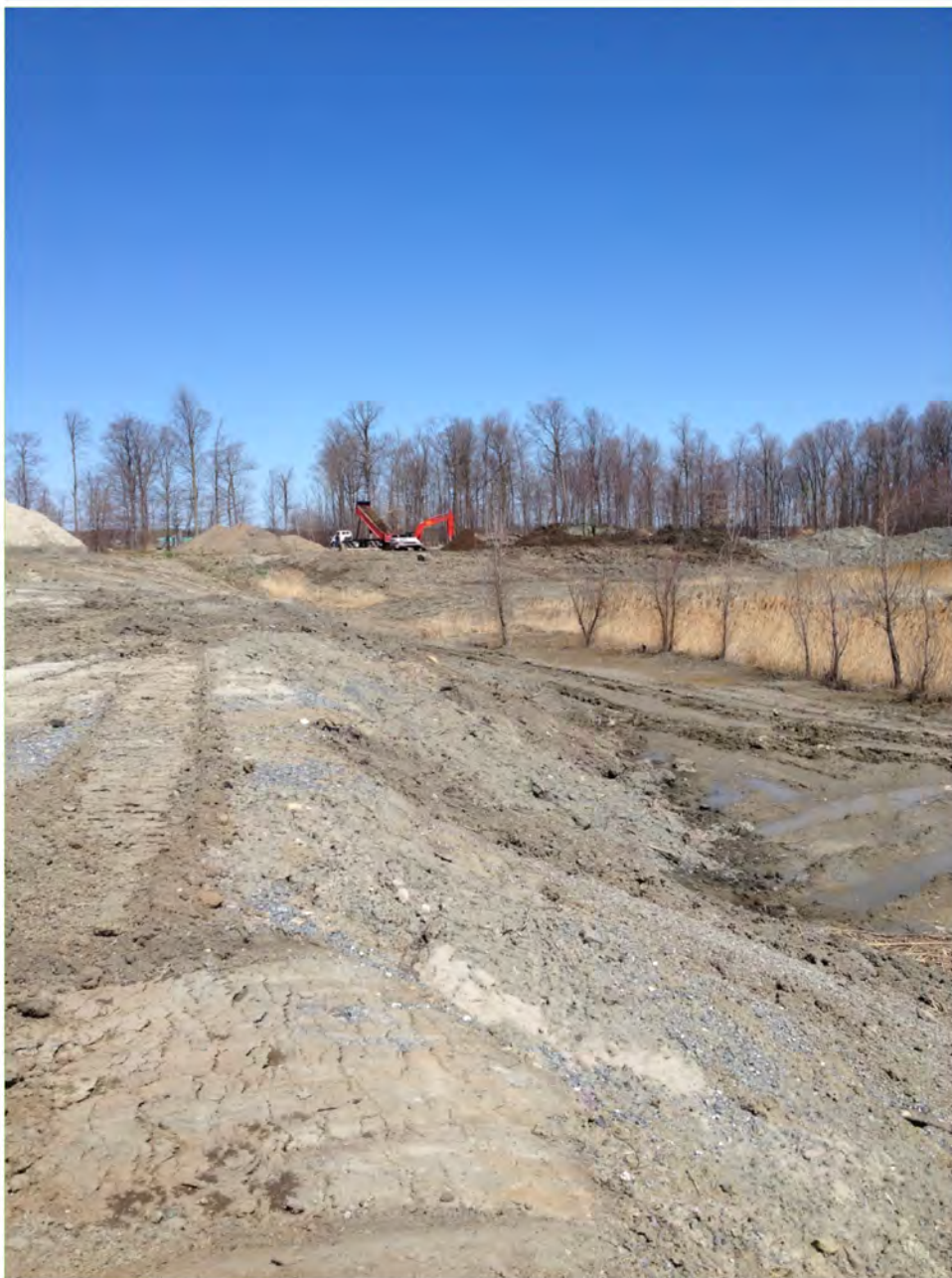
Zone des travaux de remblai.
