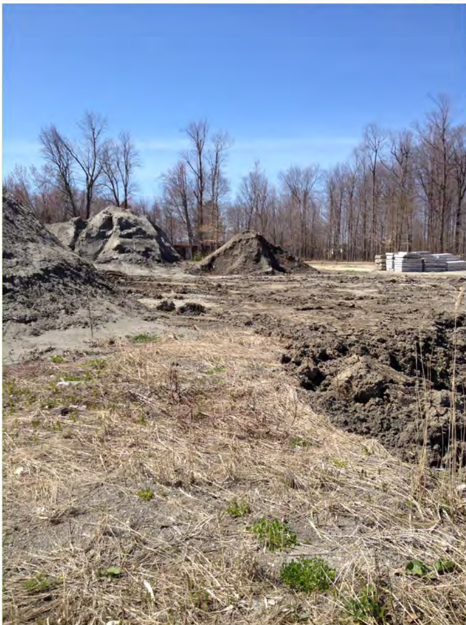
Zone des travaux de remblai.
