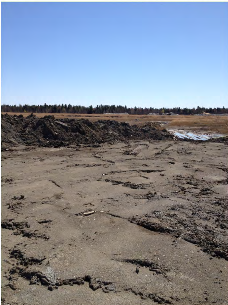
Zone des travaux de remblai.
