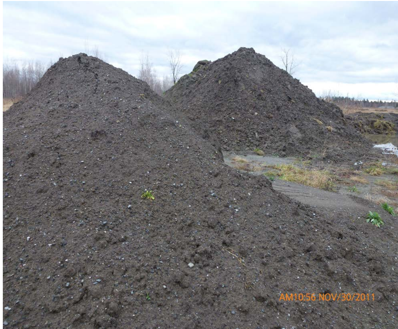
Matériel de remblai
