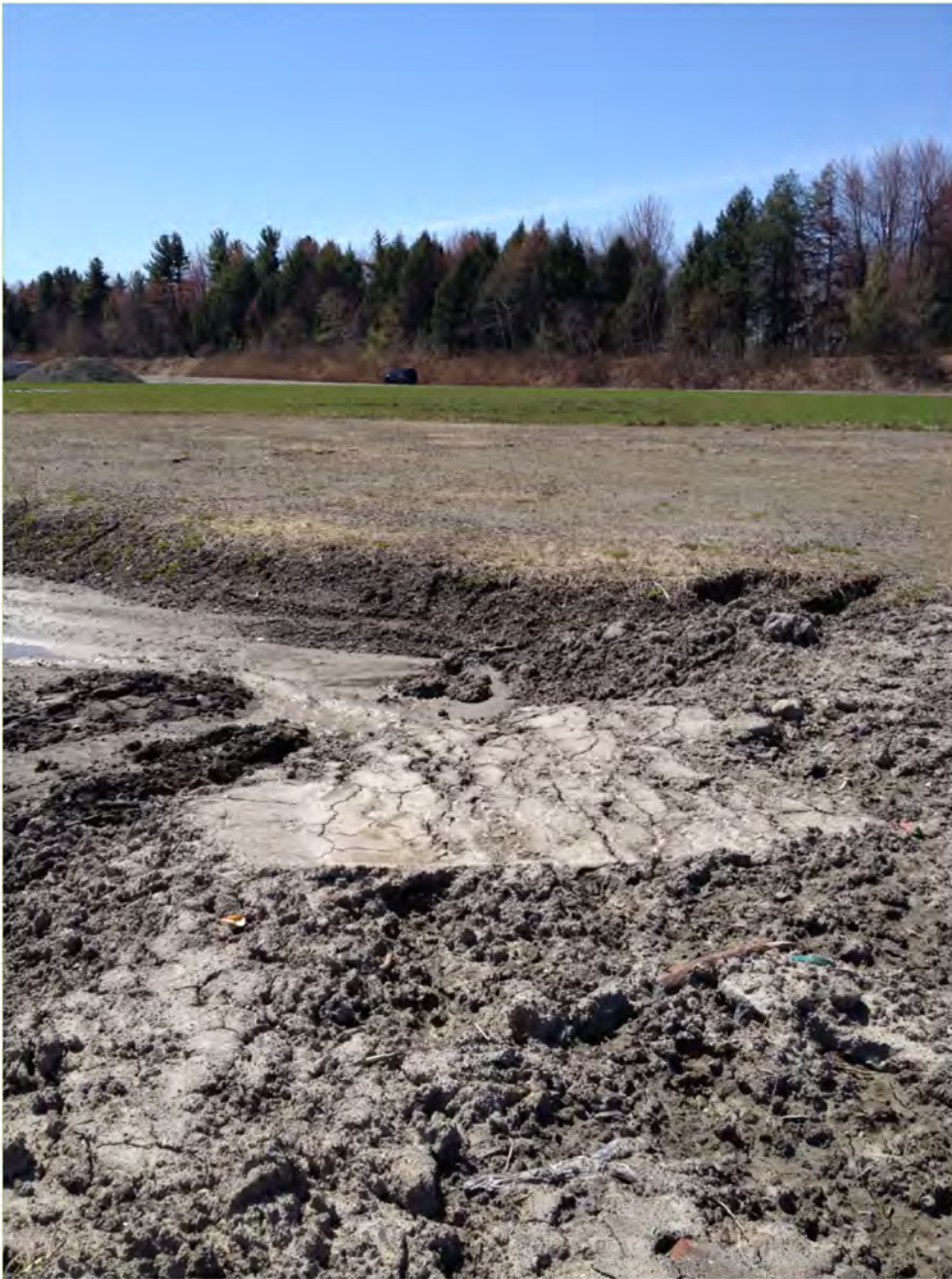
Trois étapes; prairie fourragère établie au fond, partie dont le nivellement est terminé prête à être semée et partie en voie d'être remblayé en avant plan.
