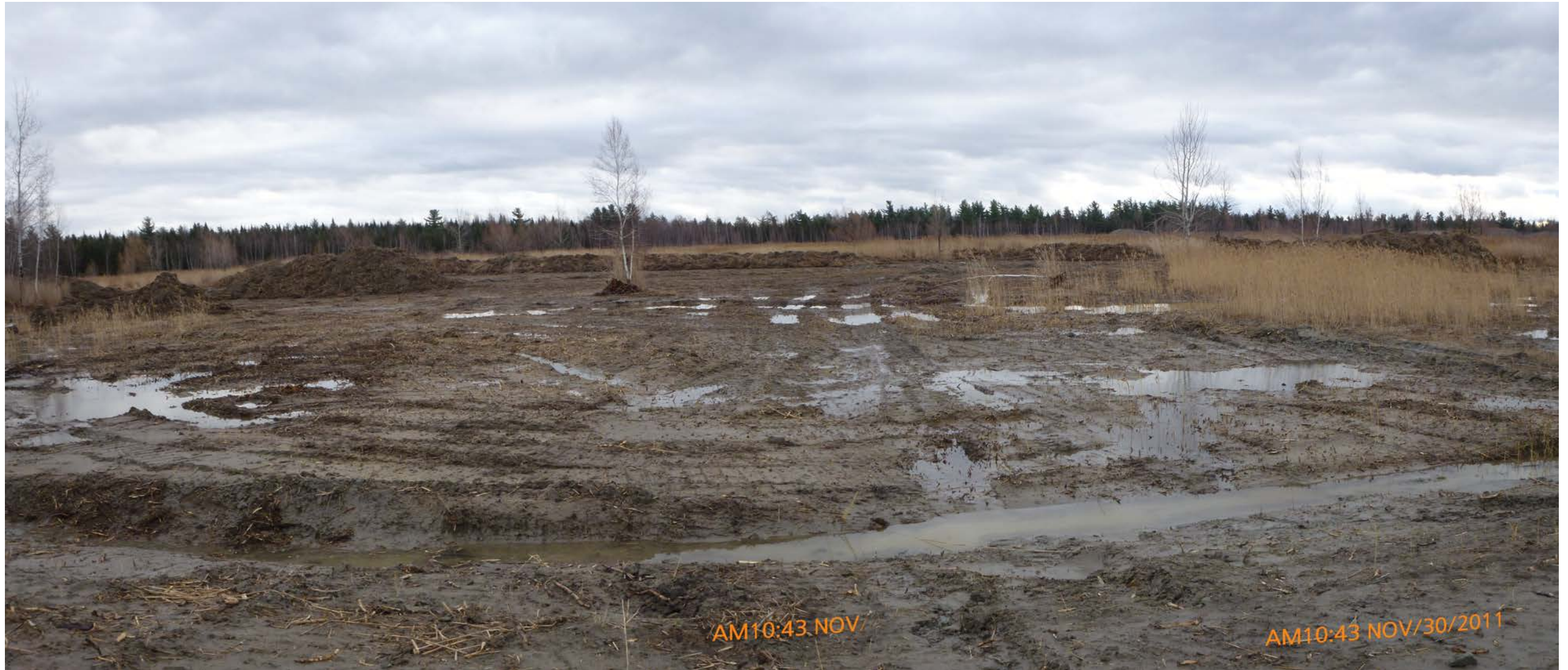
Décapage de la couche de surface du plancher de la sablière et mise en andains pour compostage
