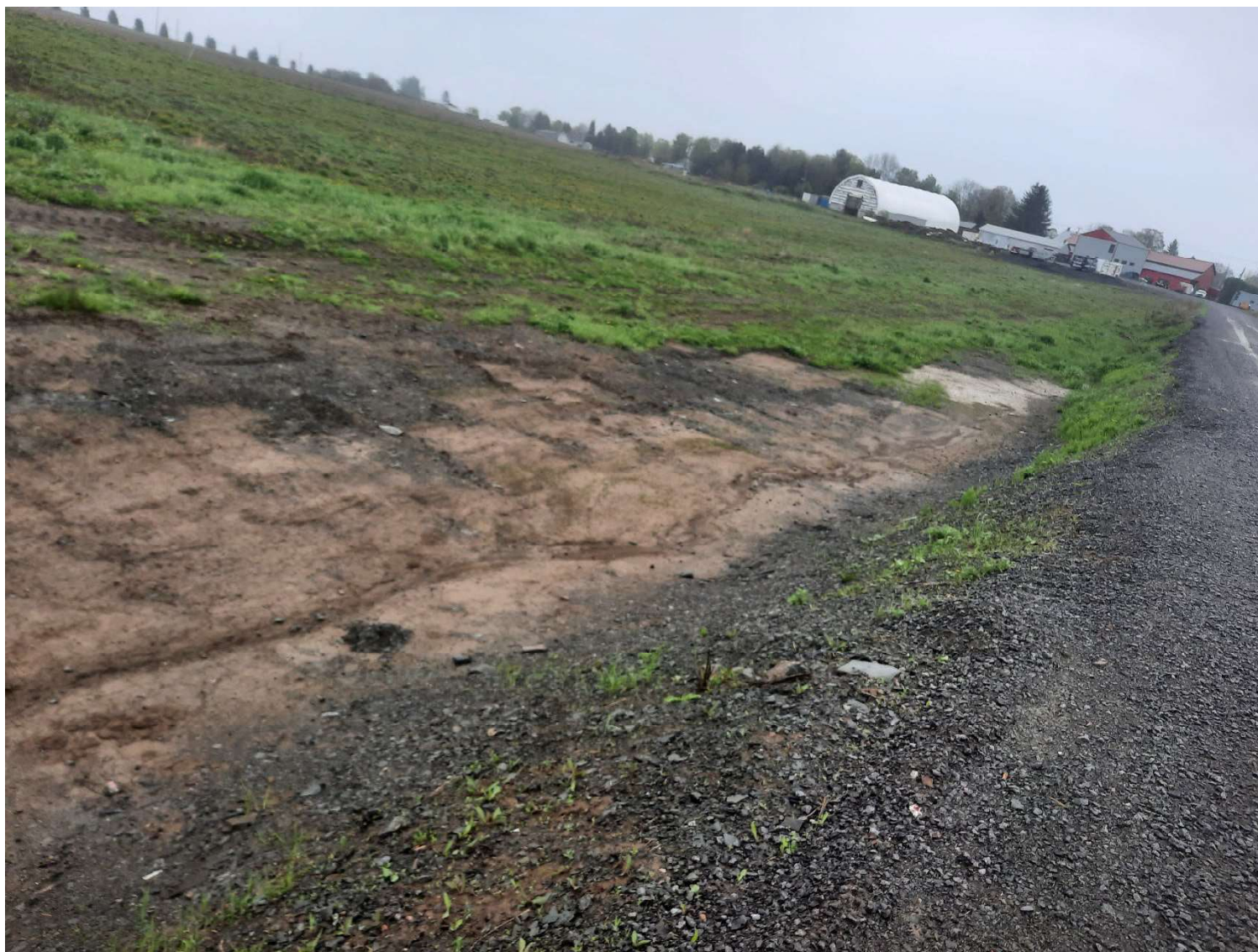
Photo 7. Bordure du chemin d'accès qui a été travaillé, présence de gravier
