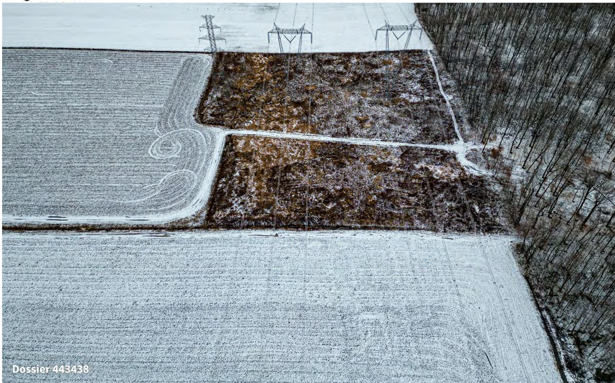
Photo 4 : Superficie sur un lot à proximité. L'enquête a déterminé qu'il s'agit de matériaux issus d'un nettoyage des fossés sur le lot et ne fait pas l'objet d'une infraction à la Loi.
